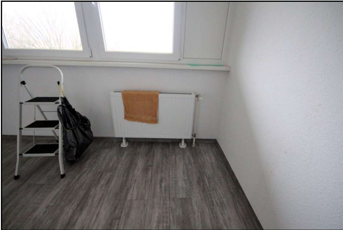
Bild 16: erneuerte Heizkörper und Fenster
