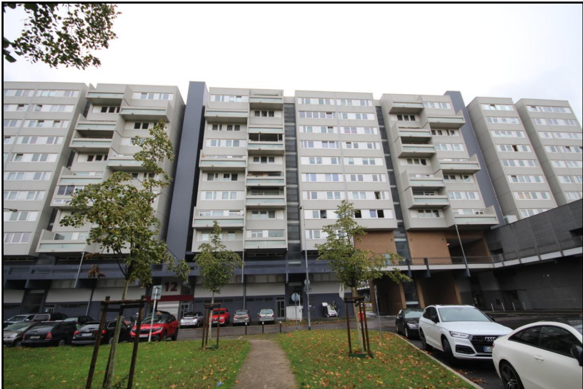
Bild 4: Ansicht Adolf-Grimme-Straße 12, 14 von Nordwesten
