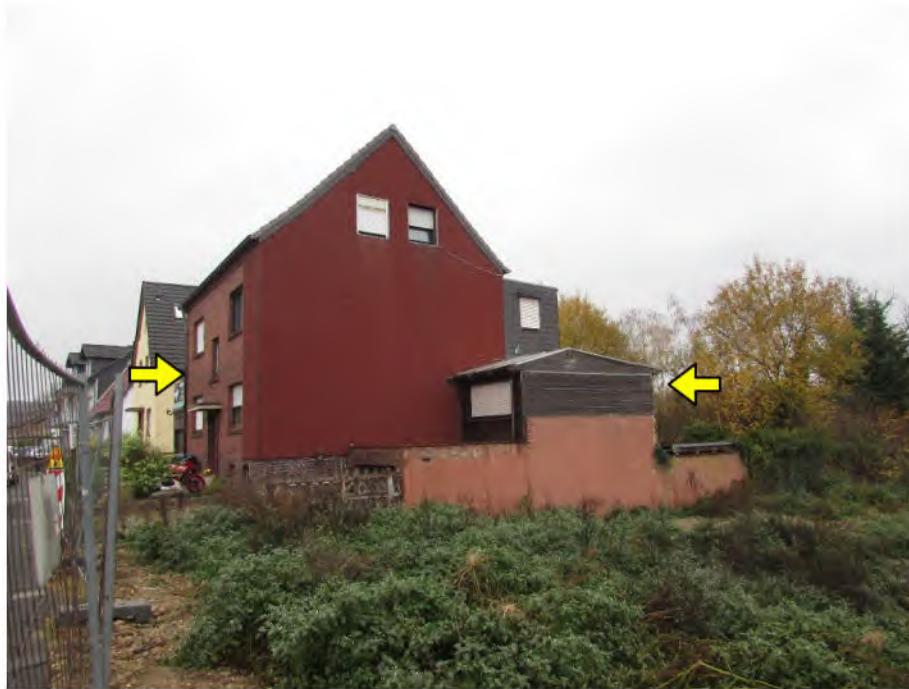
Foto 1: Wohnhaus mit rückwärtigem Anbau und Garage
