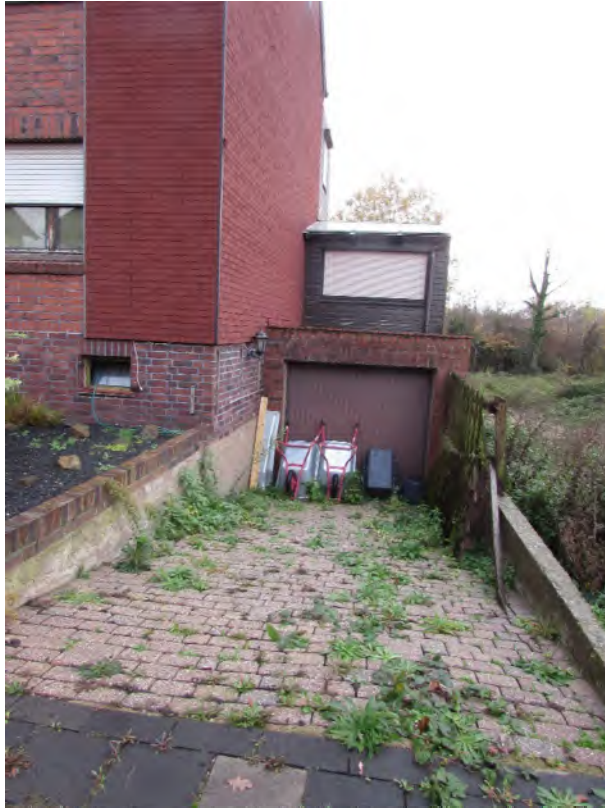
Foto 9: Garage mit verunkrauteter Zufahrt
