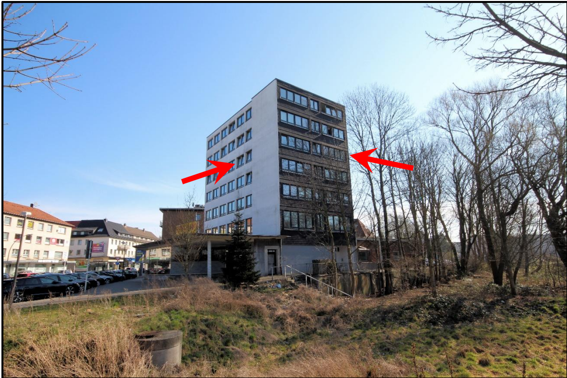
Bild 11: Ansicht von Nordwesten
