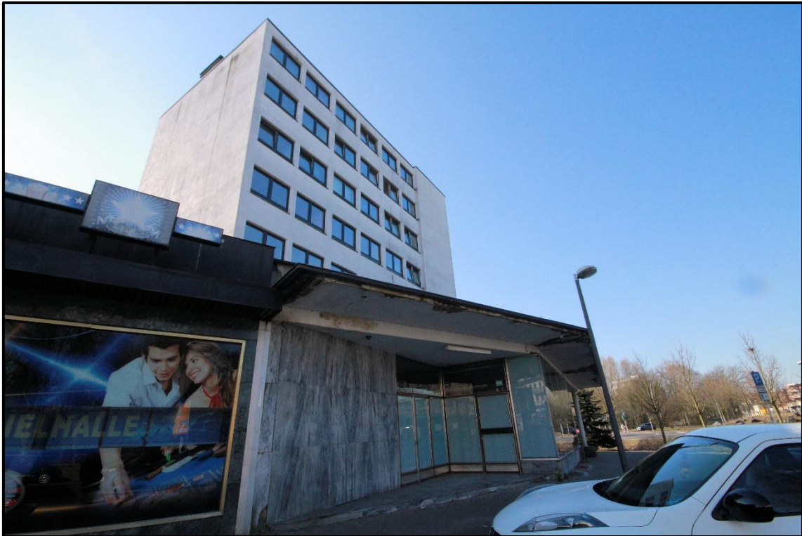
Bild 7: Ansicht von Nordosten
