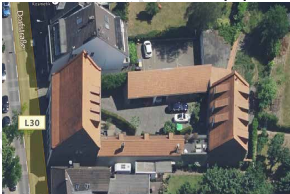
Luftbild Blick von Westen, Quelle bing maps
