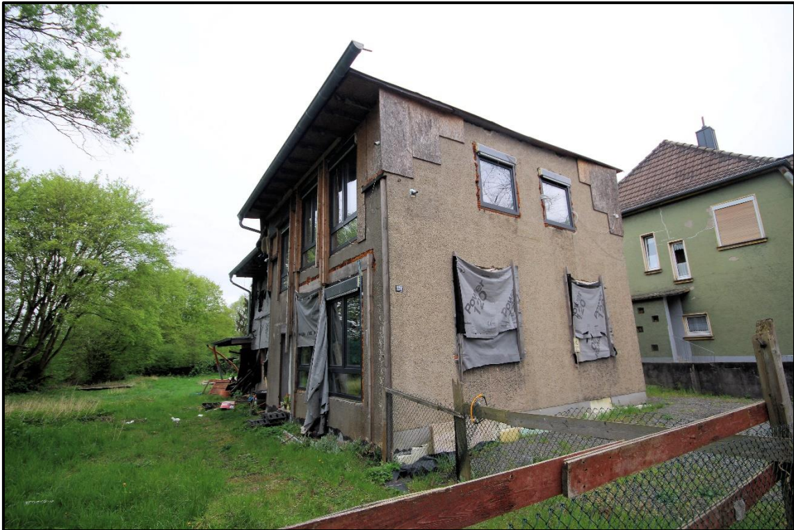
Bild 5: Ansicht von Süden
