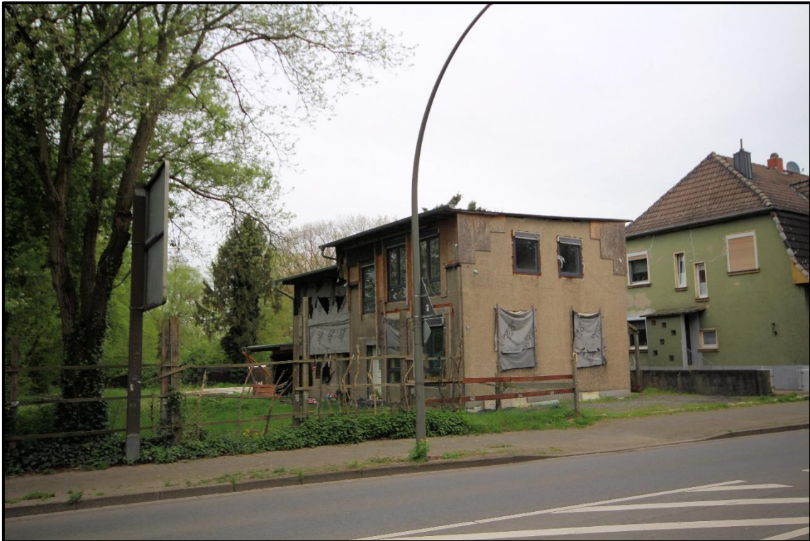
Bild 3: Ansicht von Süden
