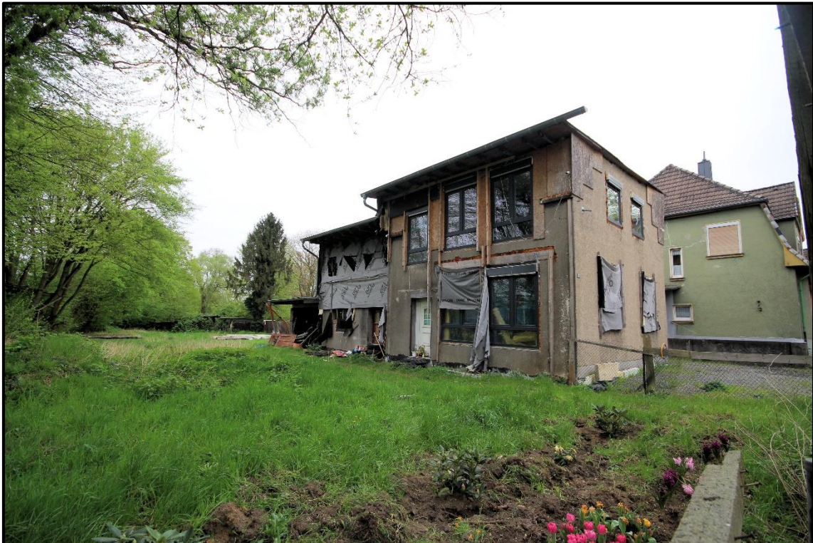
Bild 4: Ansicht von Südwesten
