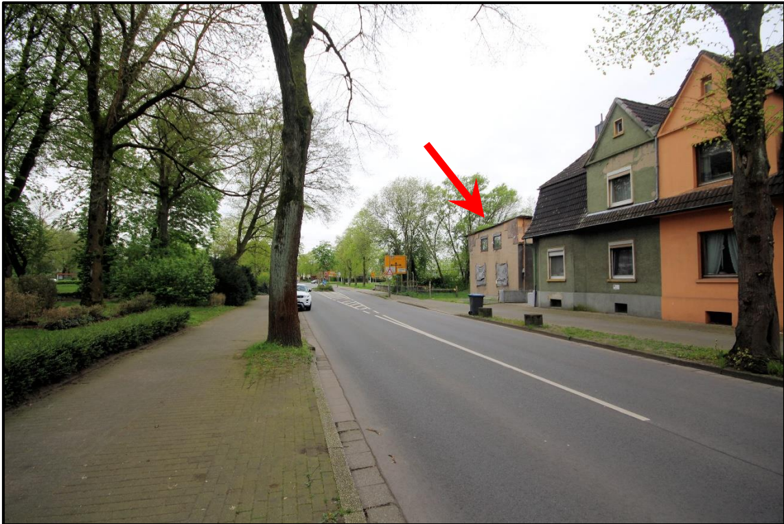
Bild 1: Blick in die Schachtstraße nach Südwesten
