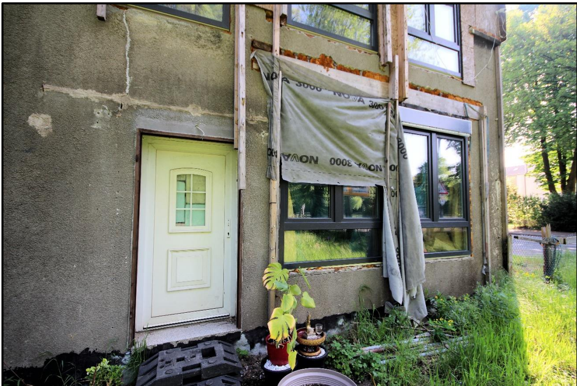
Bild 14: Hauseingangsbereich an der Südwestseite
