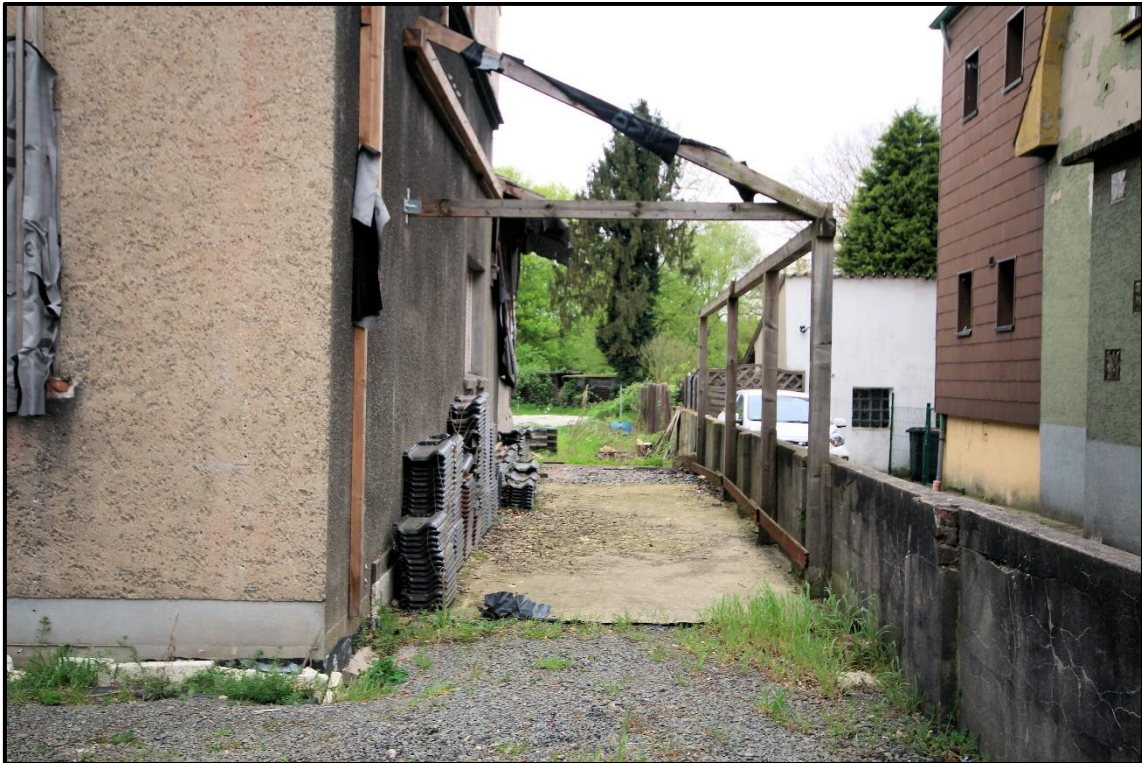
Bild 9: seitlicher Stellplatz an der Nordostseite
