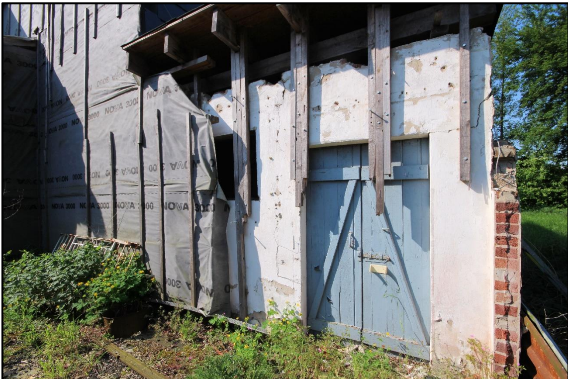
Bild 10: Nordostseite des Anbaus
