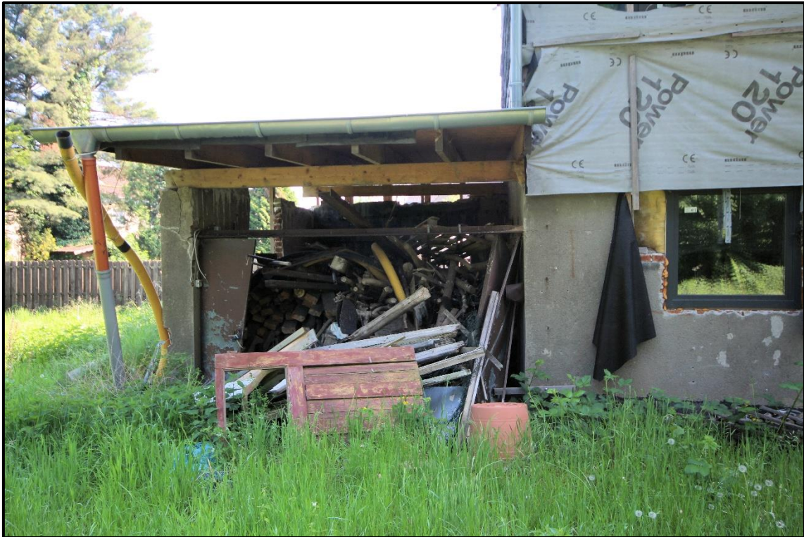
Bild 13: Südwestseite des Anbaus
