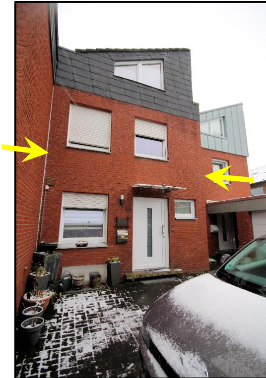
Bild 3: Ansicht von Nordosten
