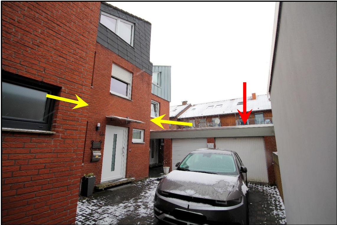
Bild 1: Eingangsseitige Gesamtansicht (Wohnhaus und Garage)
