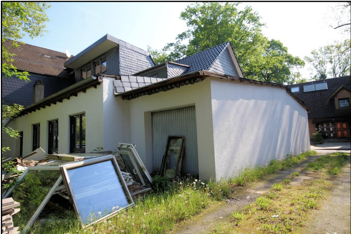
Bild 12: Ansicht von Südwesten
