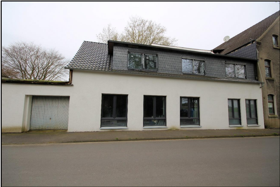
Bild 15: Ansicht des Anbaus von Osten
