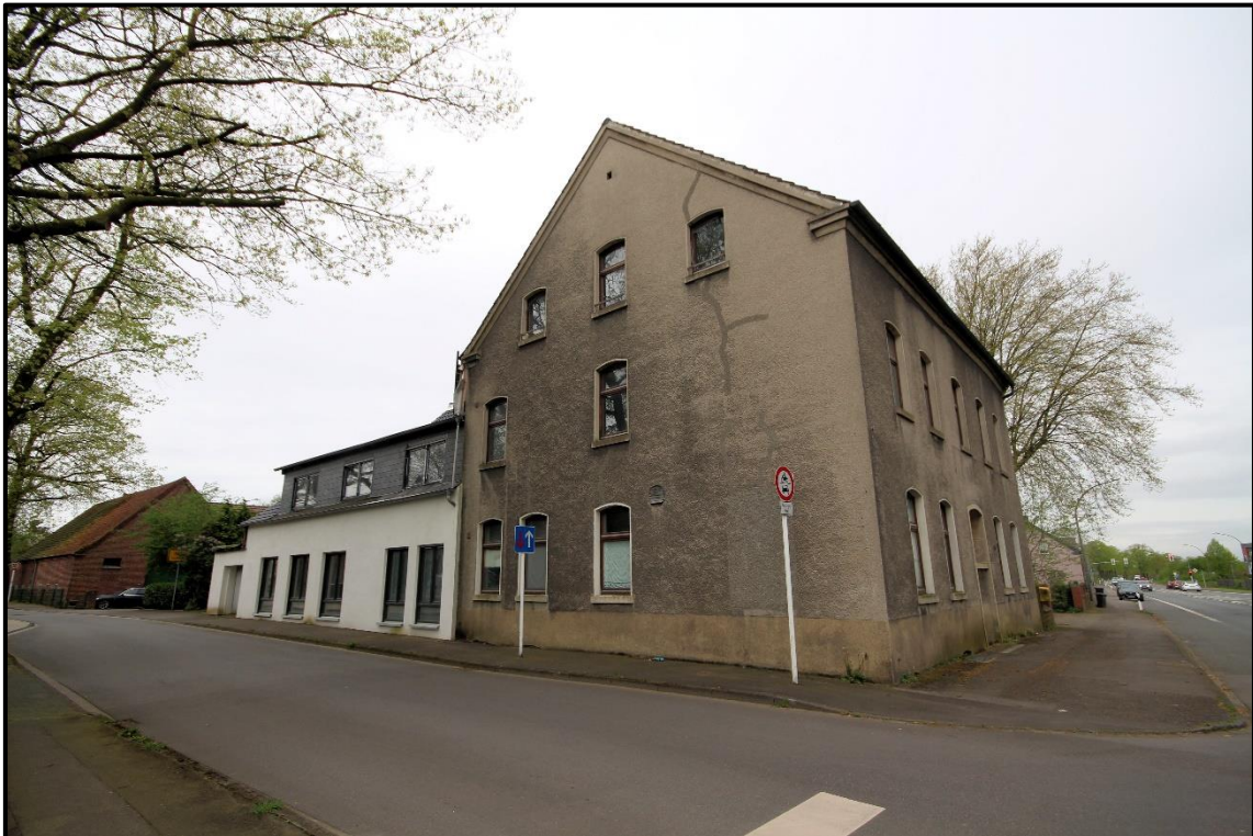
Bild 16: Gesamtansicht von Osten
