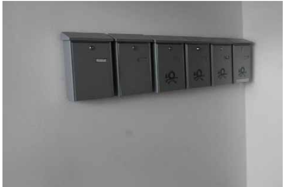
Sicht auf die Briefkästen im Flur des Eingangsbereichs / EG
