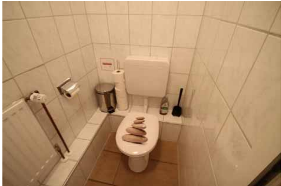
Sicht in ein WC / 1. OG
