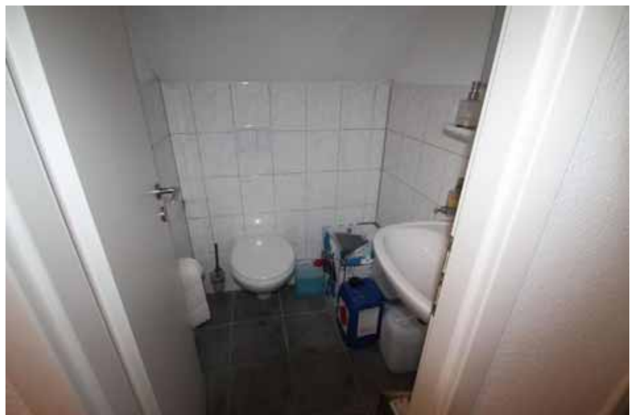
Sicht in ein WC / DG
