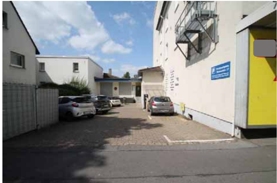
Sicht von der Schillerstraße auf die Zufahrt zum Hof mit dem rückwärtigen Zugang, der Laderampe und den Stellplätzen des zu bewertenden Objekts
