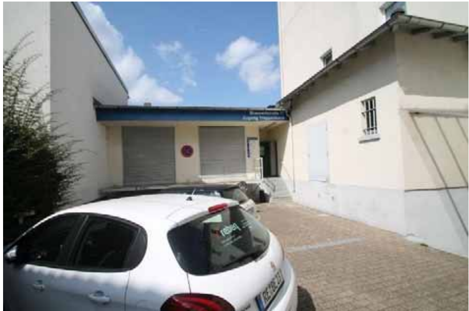
Sicht vom Hof auf die Laderampe des zu bewertenden Objekts
