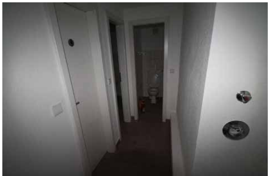
Sicht in den Sanitärbe- reich im Keller / KG
