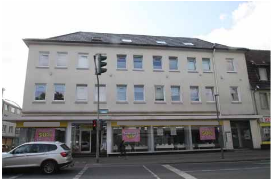
Sicht von der Brassertstraße auf die Vorderansicht des zu bewertenden Objekts
