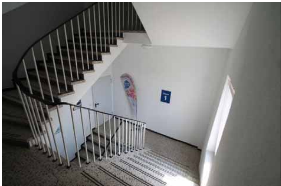
Sicht in das Treppen- haus / 1. OG-2.OG
