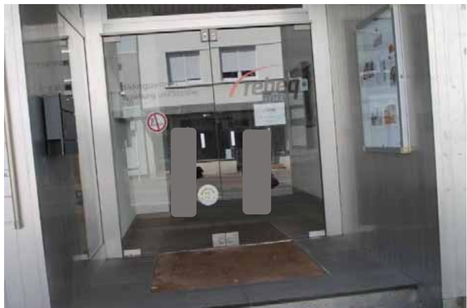
Sicht auf den Eingangsbereich zu den Büroeinheiten an der Vorderseite des zu bewertenden Objekts
