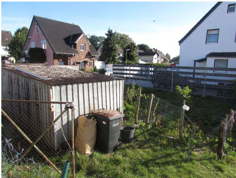
Foto 2: vorderer Grundstücksbereich, Blechgarage
