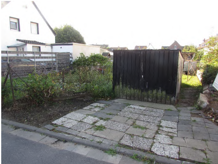
Foto 1: vorderer Grundstücksbereich, Blechgarage, unebene, schadhafte Befestigung
