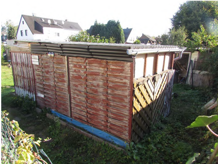
Foto 6: rückwärtiger Grundstücksbereich, Unterstand/Gartenhaus 2
