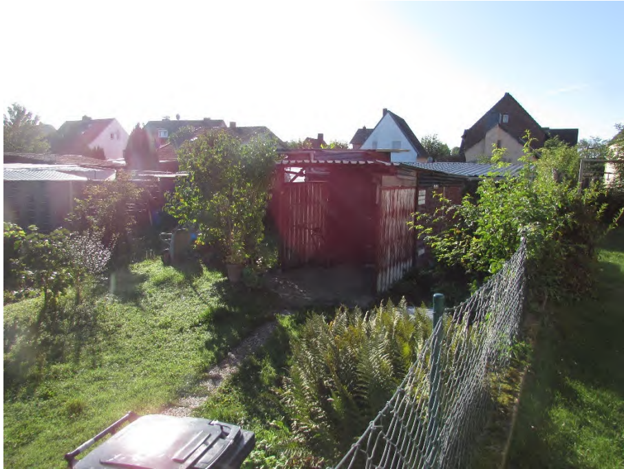
Foto 5: rückwärtiger Grundstücksbereich, Unterstand/Gartenhaus 2
