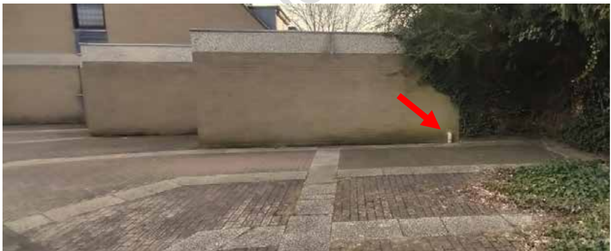
Garage Flurstück 315 und Stellplatzfläche Flurstück 313
