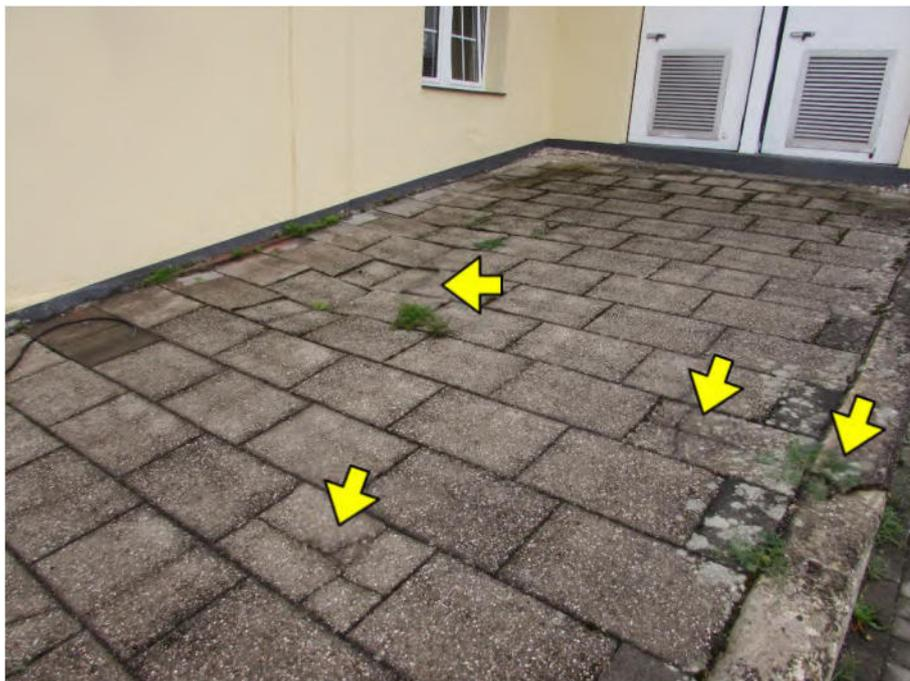
Foto 18: Rampe zum Traforaum: verwitterte, tlw. abgesetzte, tlw. gerissene Betonplattenbefestigung
