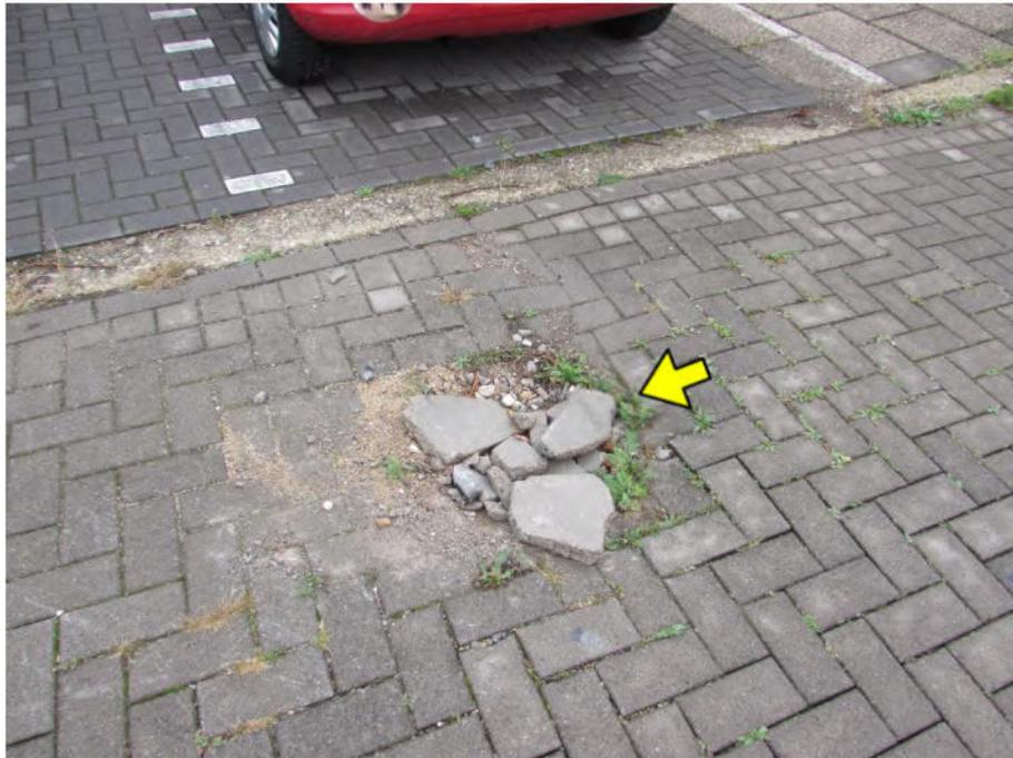
Foto 17: Zufahrt: tlw. schadhafte Betonpflasterbefestigung
