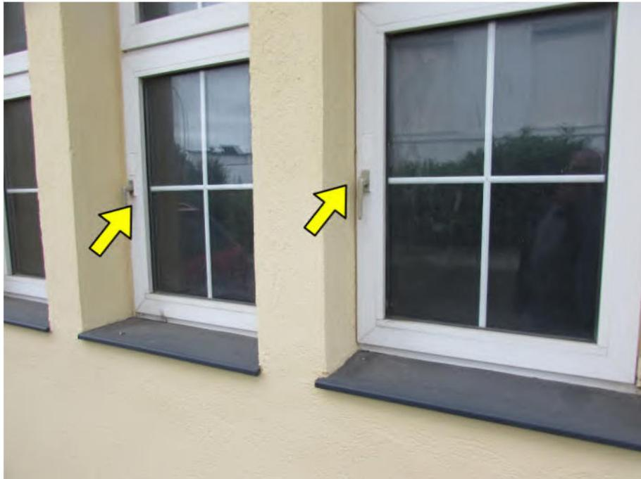
Foto 5: Traforaum, verkehrt herum eingebaute Fenster
