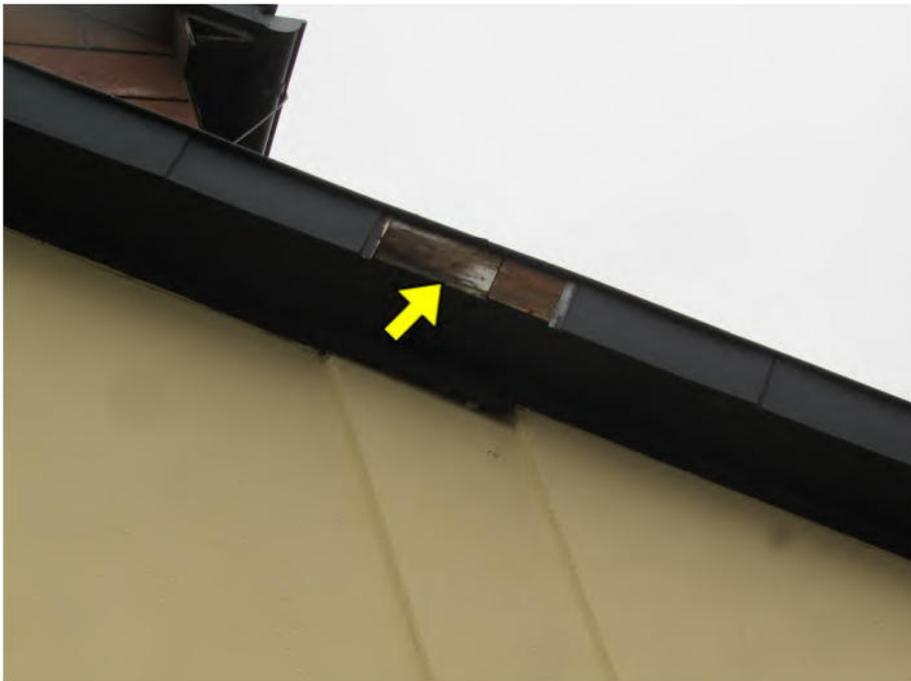
Foto 2: vereinzelt fehlende seitliche Verkleidung des Dachabschlusses
