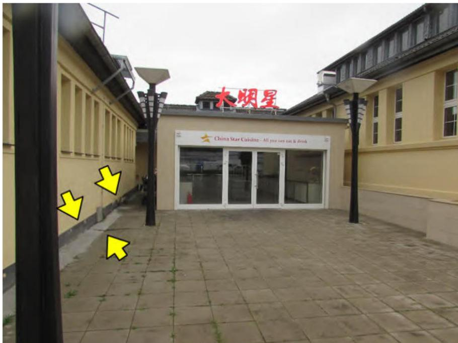
Foto 10: Nordost-Ansicht, Zwischentrakt: abgesetzte Betonplatten im Innenhofbereich, Feuchtigkeit im Sockelbereich der Fassade
