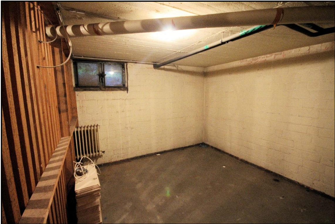
Bild 19: Kellerraum einer Wohneinheit (exemplarisch)
