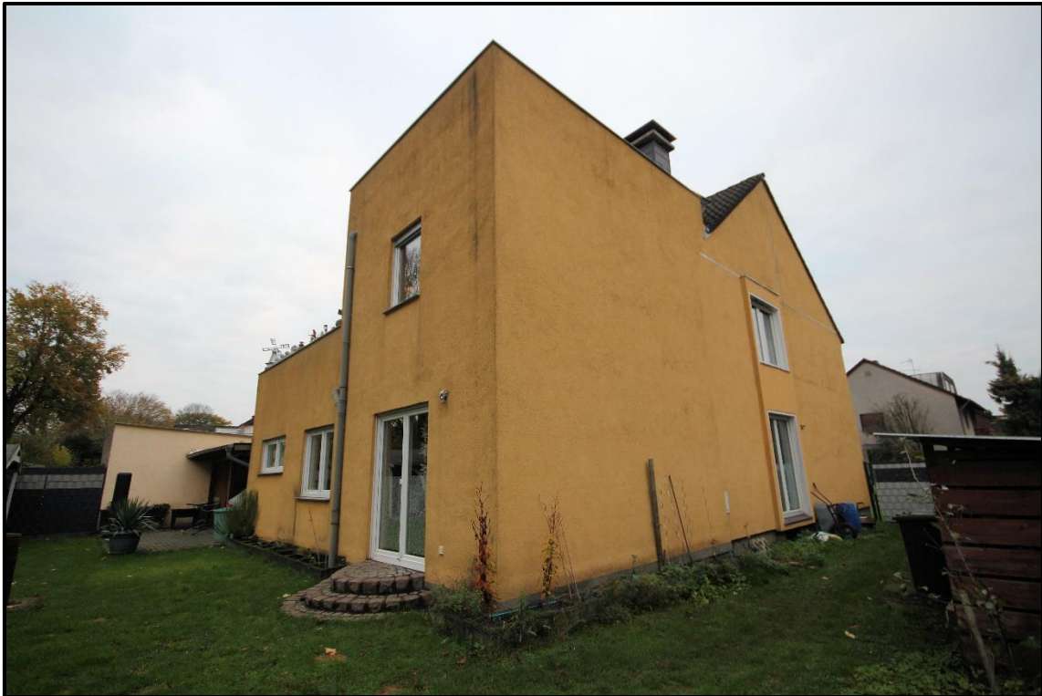
Bild 9: Ansicht von Südwesten
