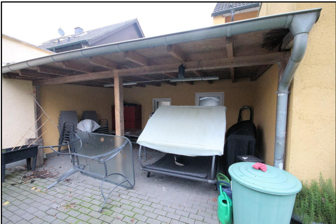
Bild 12: Überdachung hinter der Garage
