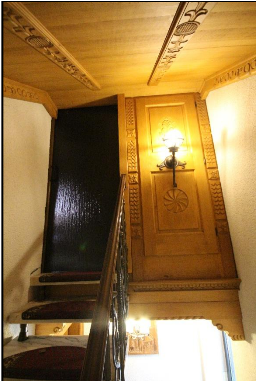
Bild 40: Treppenraum zum Dachgeschoss
