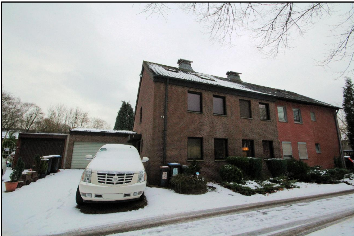
Bild 4: Ansicht von Nordosten
