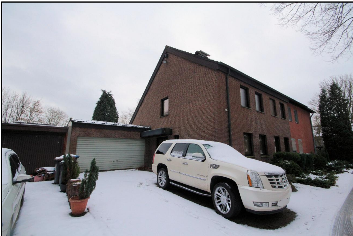
Bild 6: Ansicht von Osten
