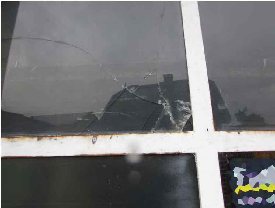
Foto 4: beschädigte Verglasung der Toranlage
