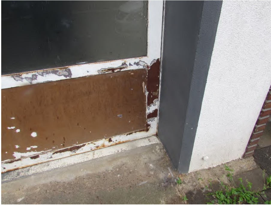
Foto 3: korrodierte Toranlage
