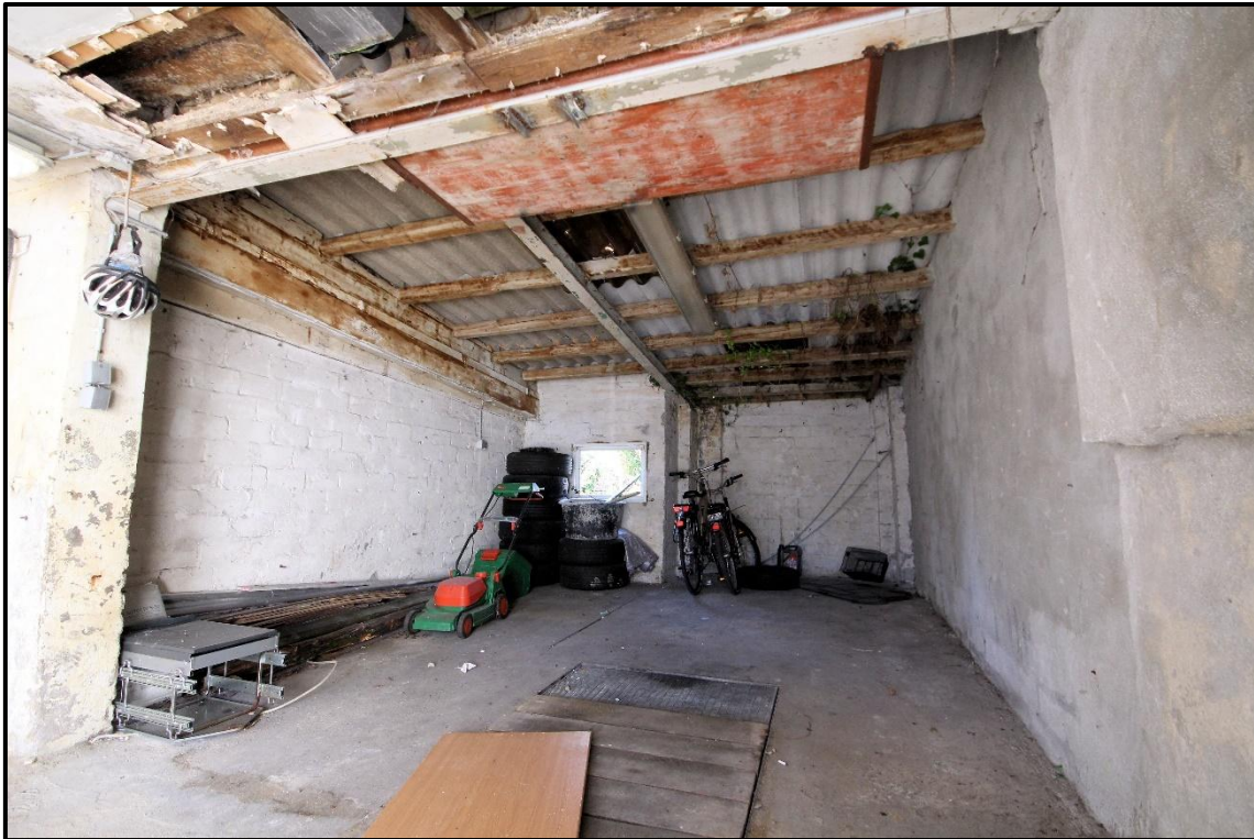
Bild 30: straßenseitig rechte Garage mit Fahrzeuggrube
