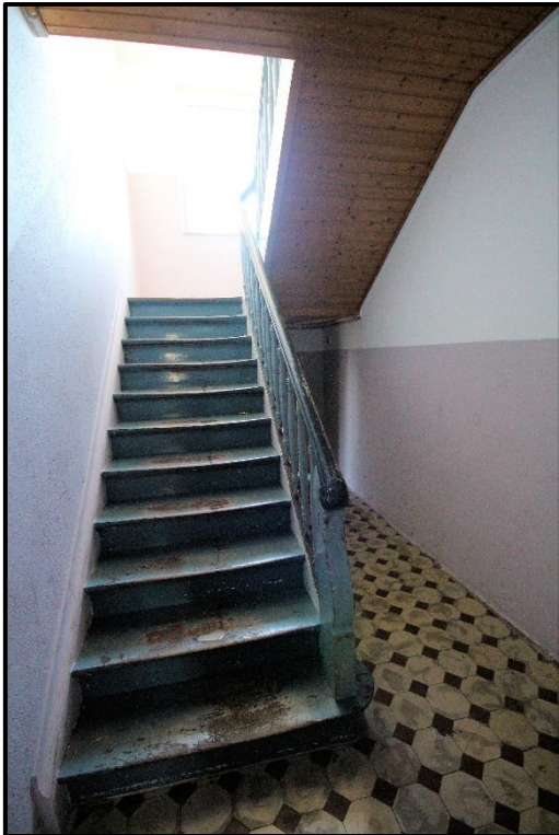
Bild 18: Treppenhaus im Erdgeschoss
