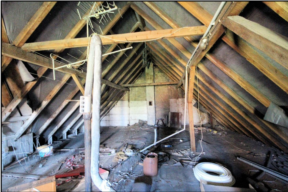
Bild 26: Dachbodenraum mit erneuerter Dacheindeckung 2000/2001
