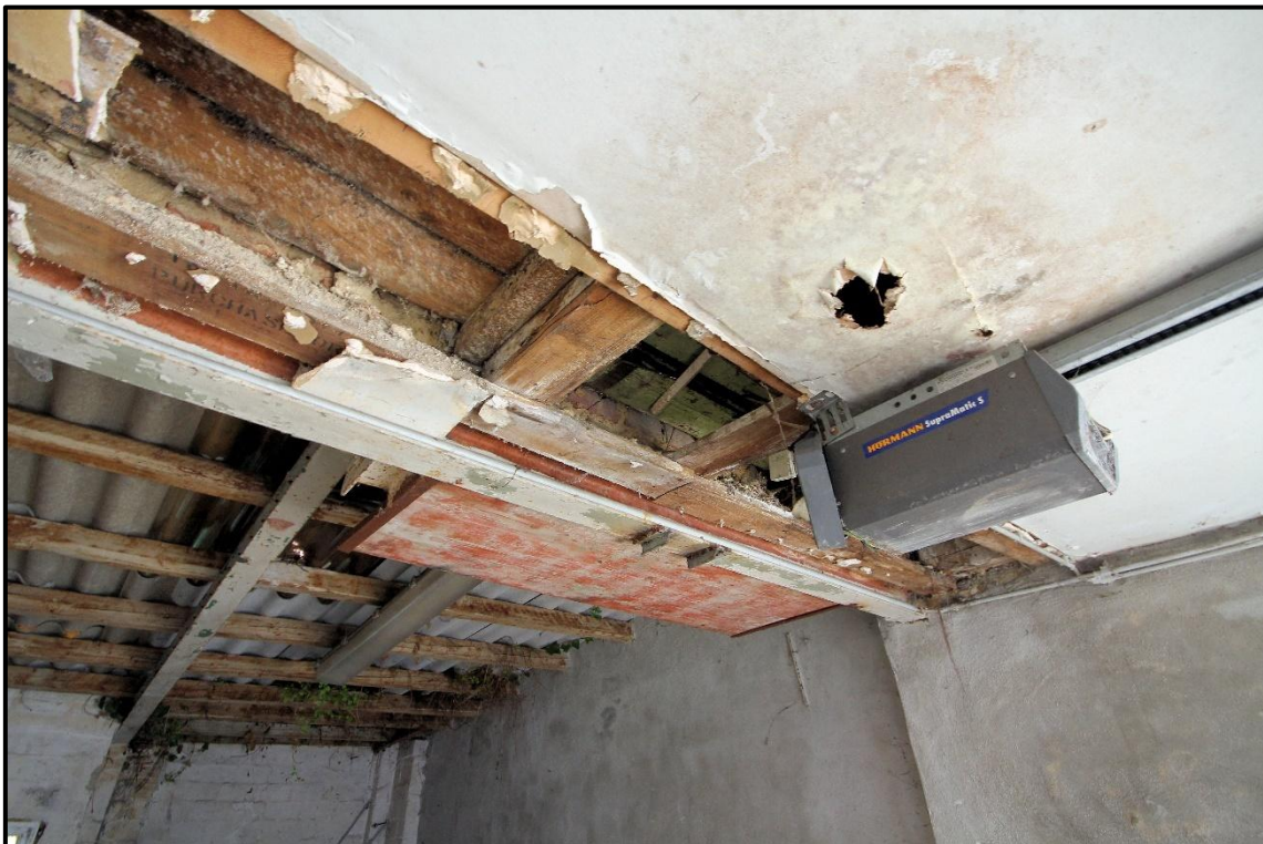
Bild 31: Dachkonstruktion der straßenseitig rechten Garage
