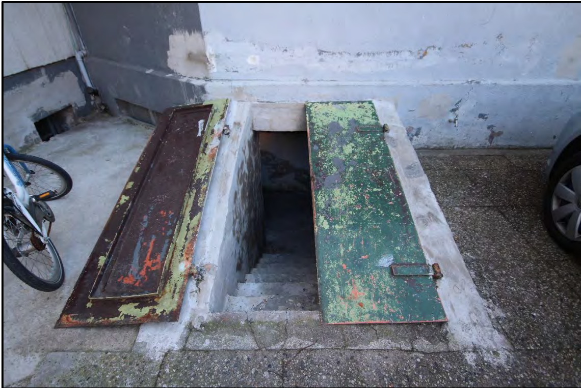
Bild 15: Eingang zum Kellergewölbe des seitlichen Anbaus
