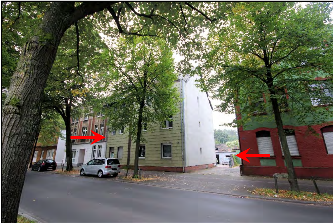
Bild 3: Ansicht von Nordosten
