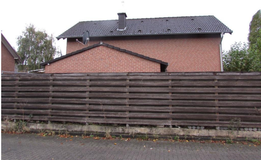
Foto 5: seitliche Ansicht, von der Straße "Im Kirchblick"
