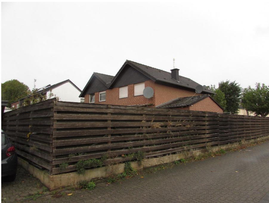
Foto 6: rückwärtige Ansicht, von der Straße "Im Kirchblick"
