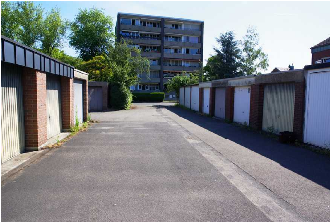
Bild 6: Ansicht der Zufahrt zum Garagenhof
