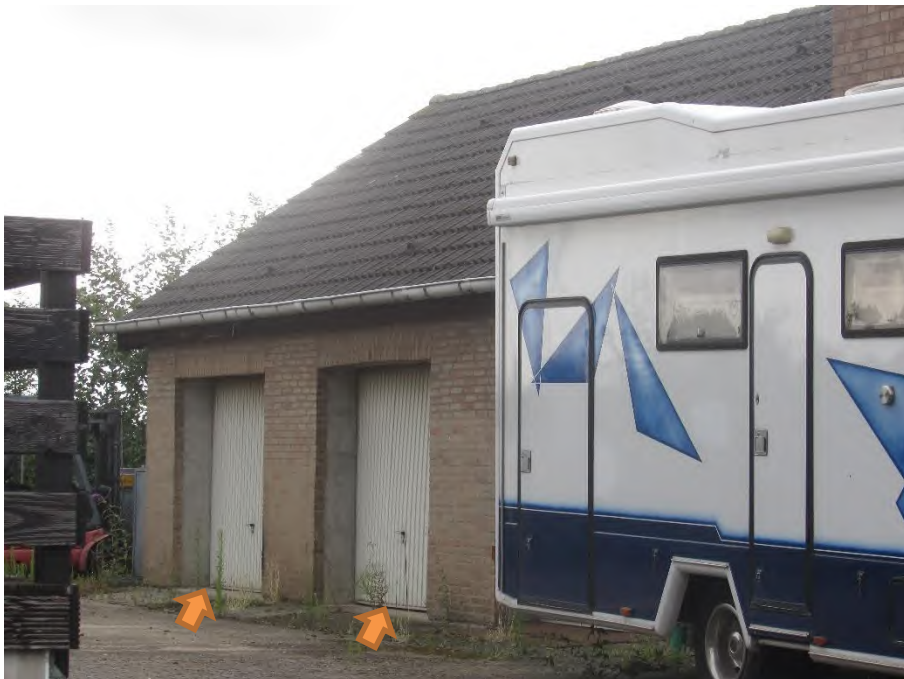
Foto 8: Garagengebäude, Sondereigentum PKW-Garagen Nr. 2
