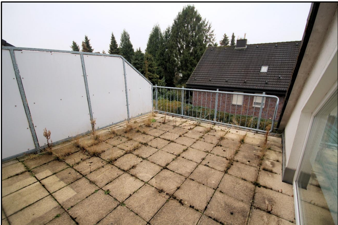
Bild 48: Dachterrasse der Wohneinheit 8 im Dachgeschoss rechts
