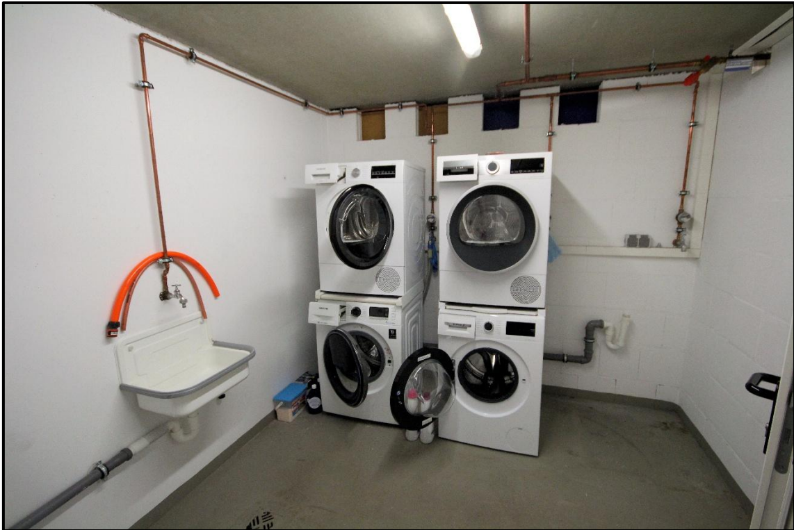
Bild 20: Waschraum im Kellergeschoss
