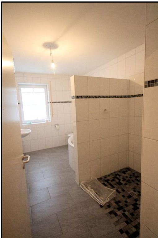
Bild 38: Bad der Wohneinheit 3 im Erdgeschoss rechts
