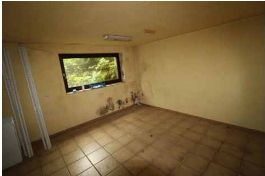
Sicht auf einen Feuchteschaden mit Schimmelpilzbefall am Kelleraußenmauerwerk im Kellerraum / KG
