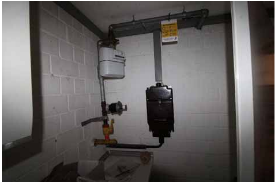
Sicht auf den Gasanschluss, Gaszähler und Hauptstromanschluss / KG
