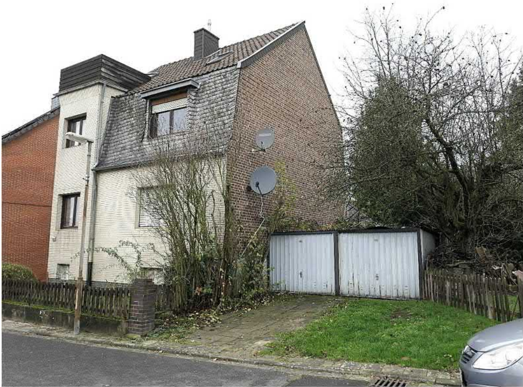
Straßenansicht von Südosten mit Blechgaragen auf dem Flurstück 95
