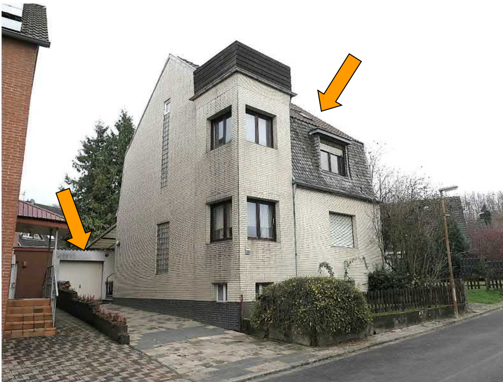
Straßenansicht von Südwesten (Flurstück 93)
