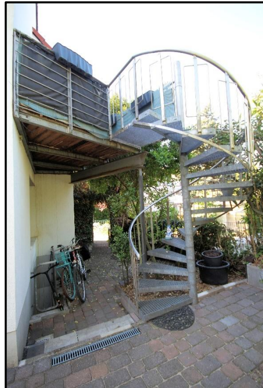
Bild 11: Gitterrost-Wendeltreppe zum Wohnungseigentum Nr. 2 im OG/DG
