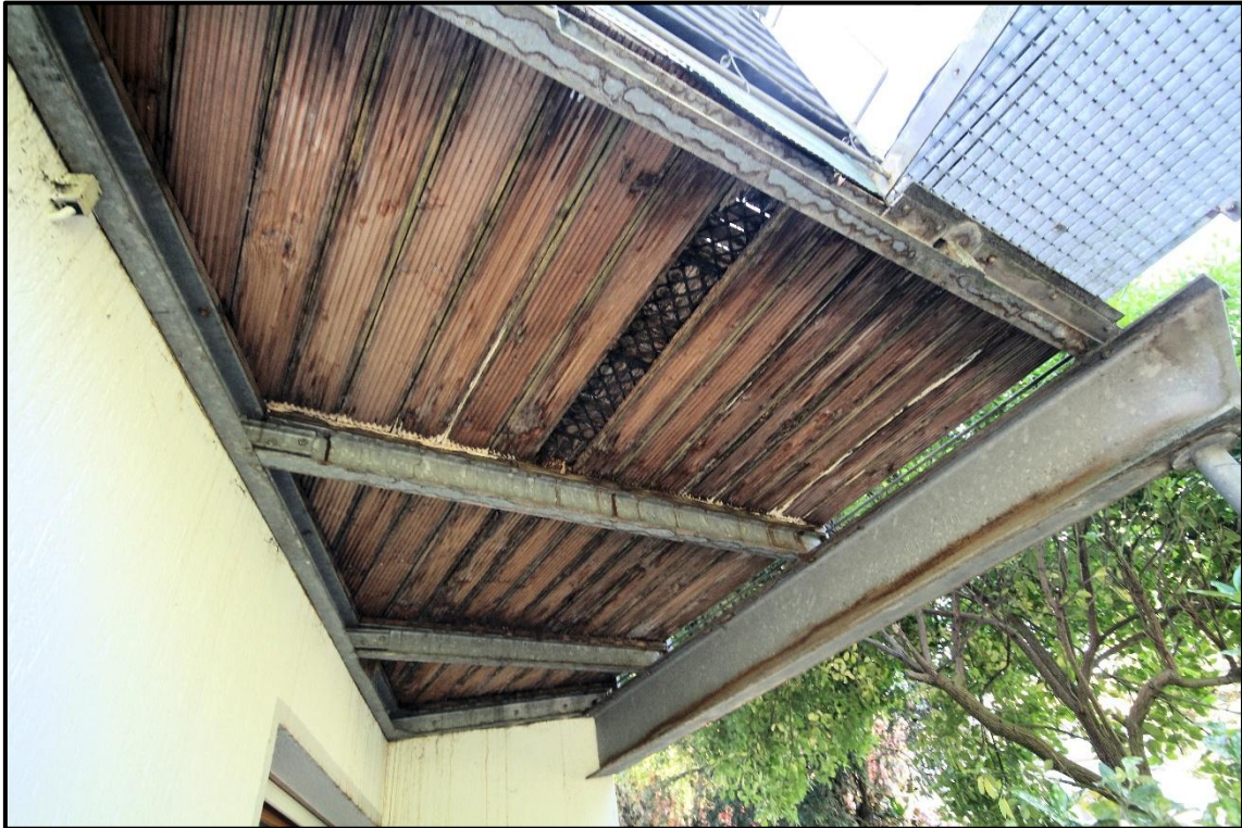
Bild 12: Balkonunterseite mit verwitterten Holzdielen
