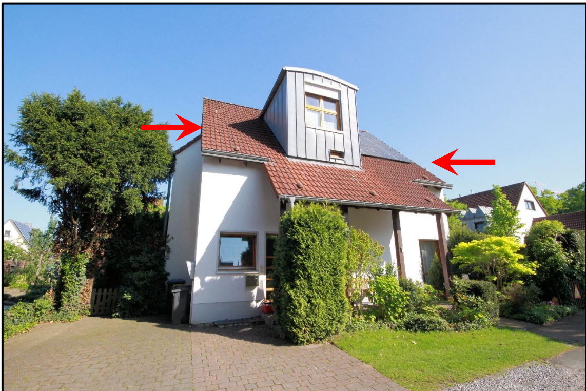
Bild 2: Ansicht von Norden
