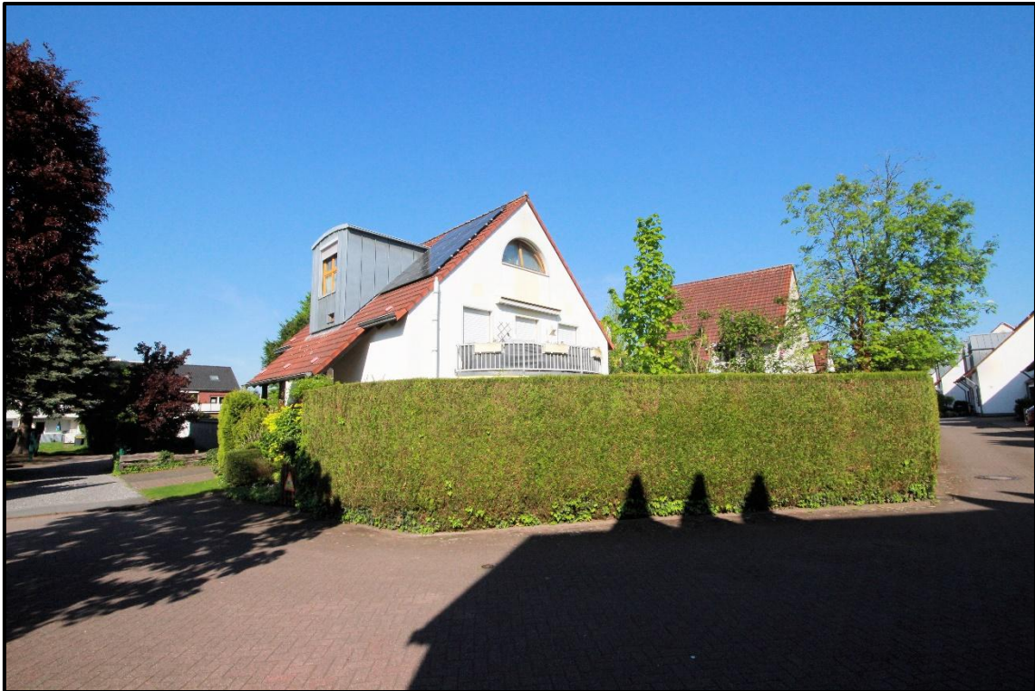
Bild 5: Ansicht von Südwesten
