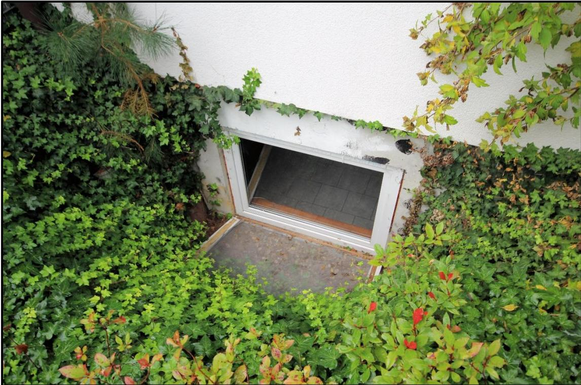
Bild 13: Lichtgraben mit Fenster zum Kellerraum 2
