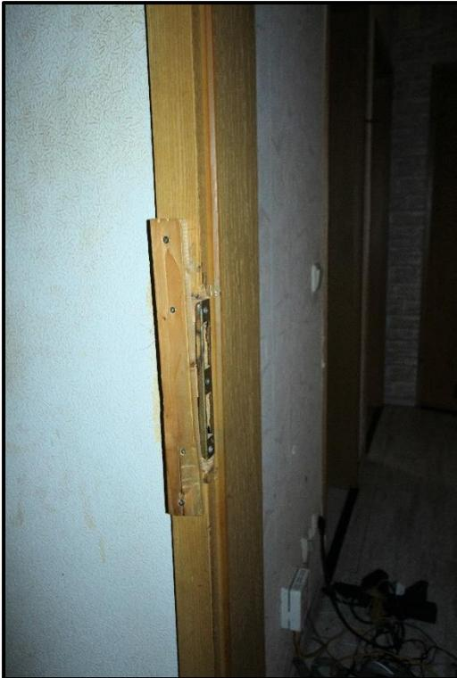
Bild 40: beschädigte Zargen und Türblätter
