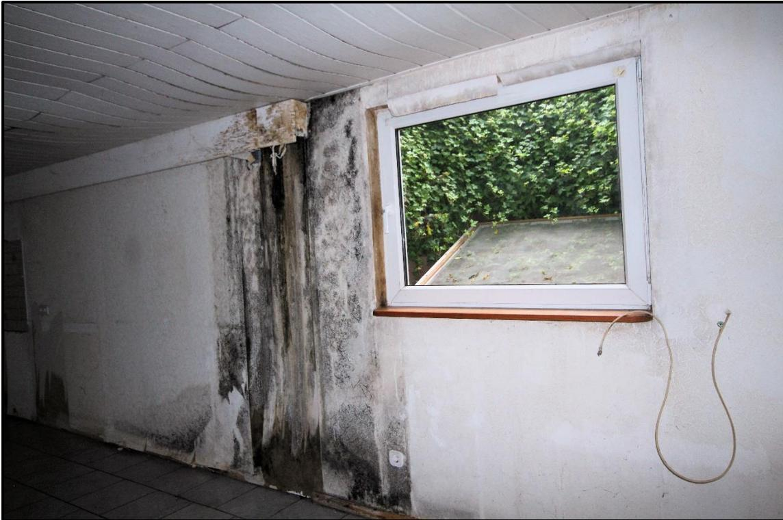
Bild 48: Feuchteschaden mit Schimmelbildung wie vor
