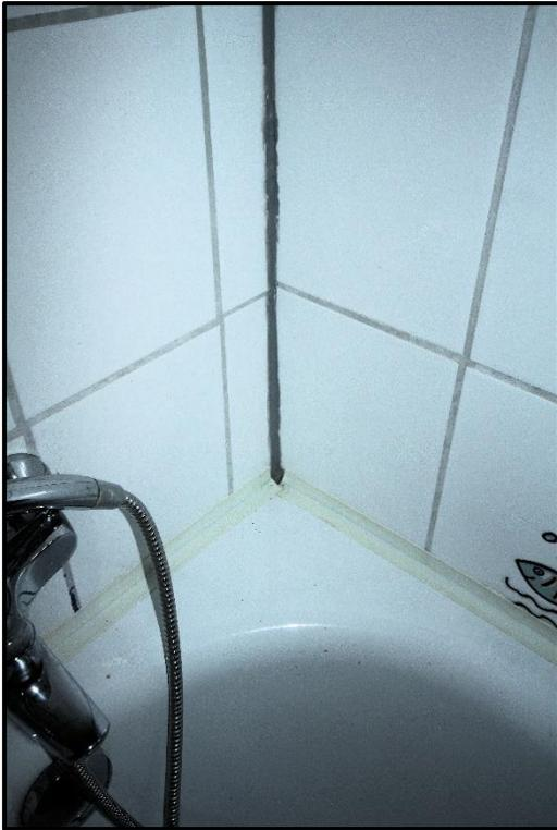
Bild 35: unsaubere dauerelastische Versiegelung und ungleichmäßiges Fugenbild im Bad der Wohneinheit Nr. 1
