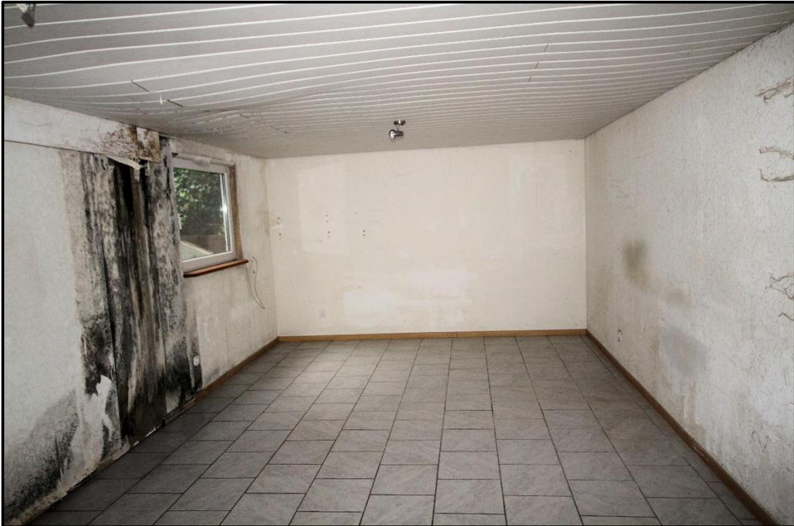
Bild 46: Keller 2 mit erheblichen Feuchteschäden und Schimmelbildung
