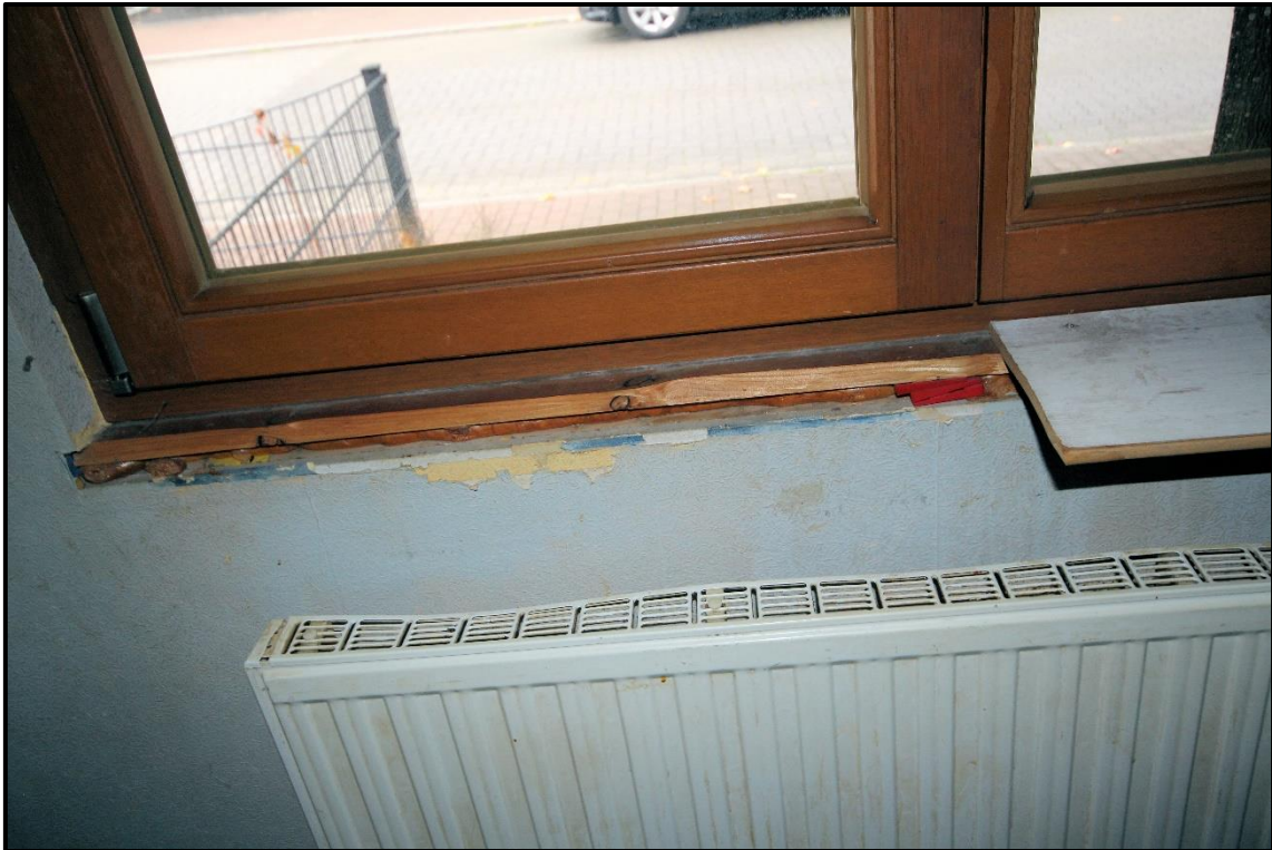
Bild 30: gebrochene Holzfensterbank und verbogene Heizungsgitter im Raum Kind 2 der Wohneinheit Nr. 1
