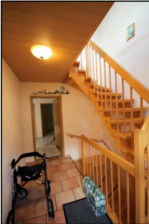
Bild 15: Treppenhaus im Eingangsbereich
