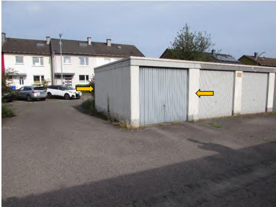
Foto 19: Flurstücke 1502, 1478 und 1446 : PKW-Fertigarage, Front-/Seitenansicht
