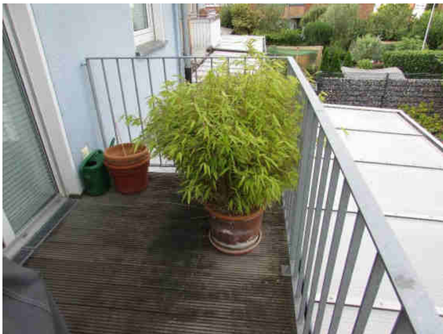
Foto 14: Wohnhaus, Obergeschoss, Balkon
