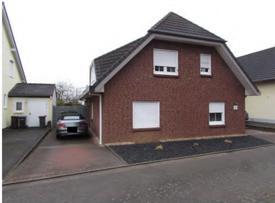
Foto 3: Zweifamilienhaus, vordere Ansicht, zwei hintereinander gelegene PKW-Außenstellplätze
