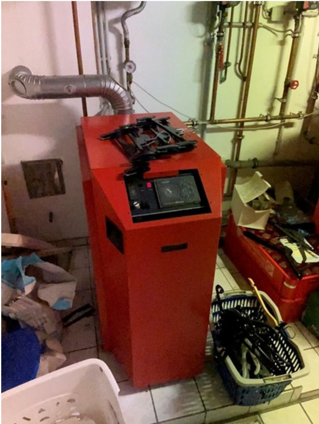
Bild 8 - Gas-Niedertemperaturkessel, überaltert
