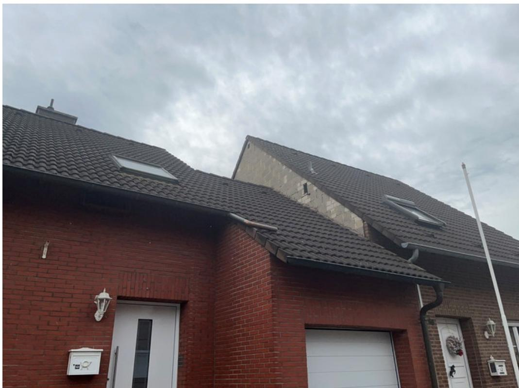
Bild 10 - nicht verputzte Giebelfläche über dach zum Nachbarn
