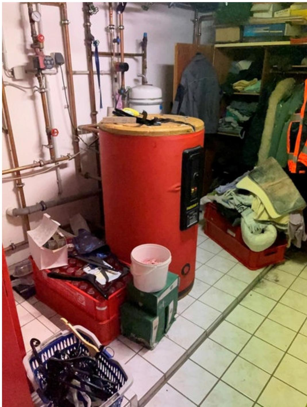
Bild 9 - Warmwasserspeicher
