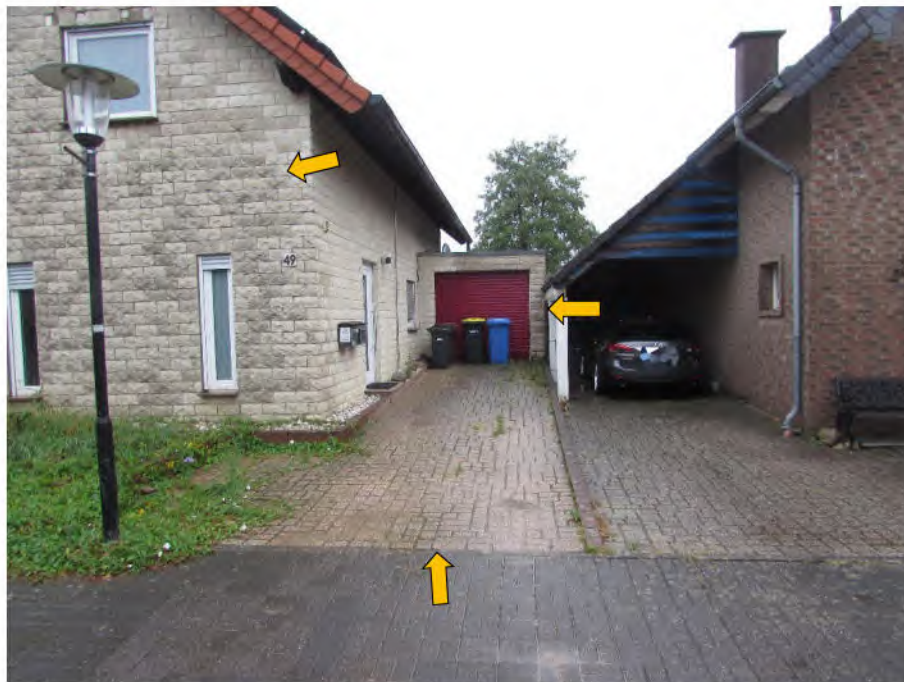
Foto 6: PKW-Garage, Straßenansicht, Zufahrt/Zugang, fleckige Fassade des Wohnhauses
