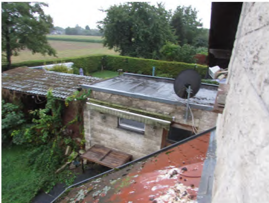
Foto 8: PKW-Garage mit angrenzendem Holzschuppen
