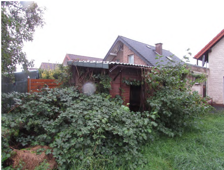
Foto 16: Holzschuppen, verwitterte Holzkonstruktion, tlw. verwilderte Eingrünung
