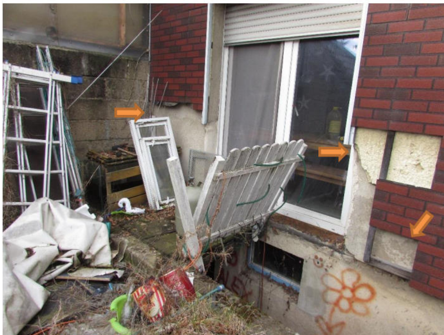
Foto 6: Wohnhaus, provisorischer Übergang der Kelleraußentreppe, beschädigte Wohnhausfassade
