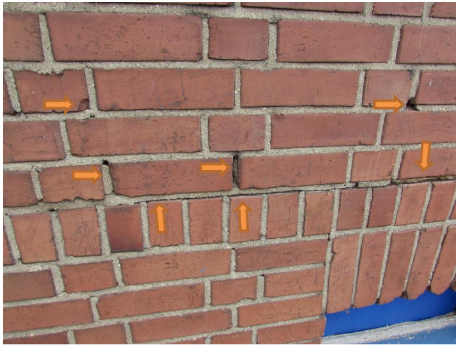
Foto 5: Wohnhaus, beschädigte Ziegelsteinfassade und Ver fugungen
