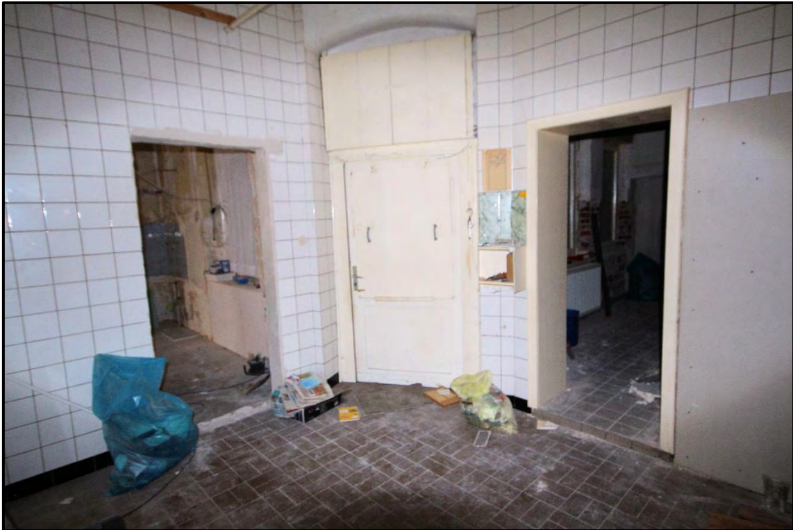
Bild 33: hofseitiger Lagerraum neben der Küche des Ladenlokals im Erdgeschoss
