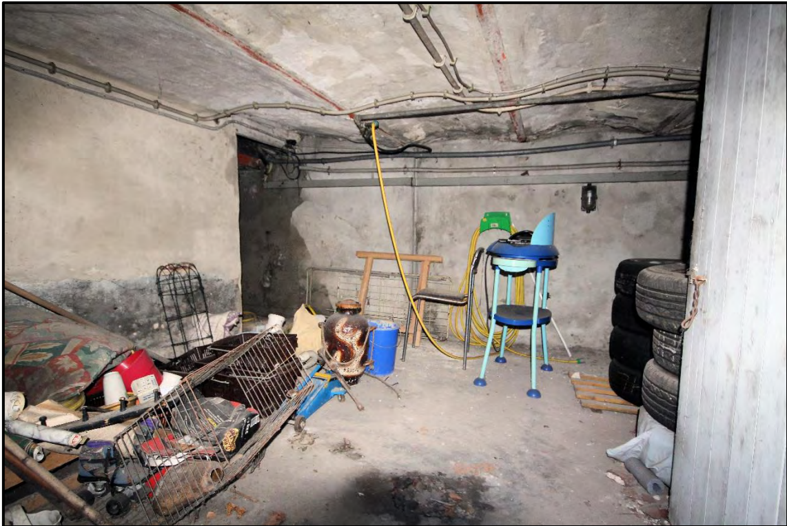
Bild 36: Kellerraum des vorderen Anbaus
