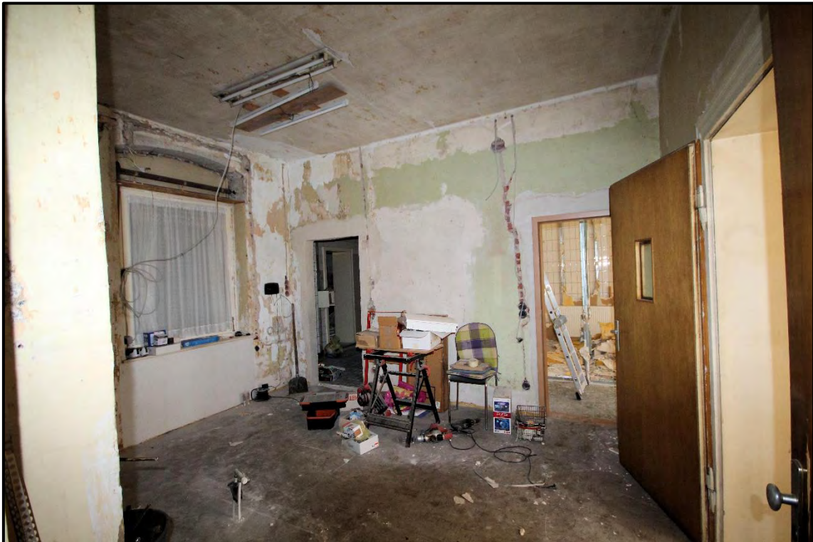
Bild 28: hofseitiger Küchenraum des Ladenlokals im Erdgeschoss
