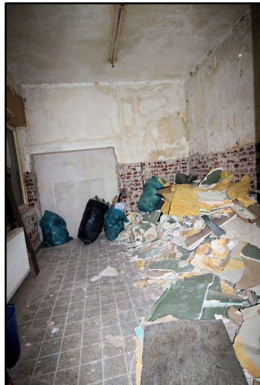
Bild 35: ehemalige Backstube im vorderen Nebengebäude im EG
