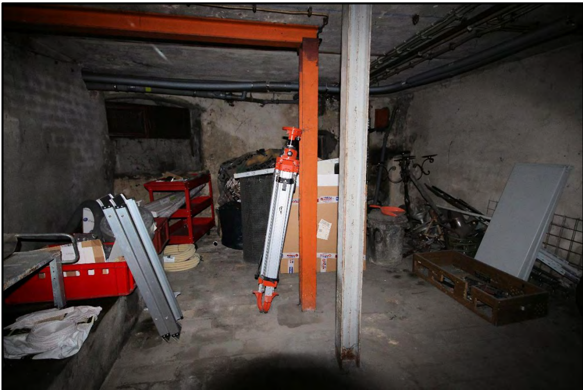
Bild 25: HE-Profile zur Stützung der Kellerdecke in einem hofseitigen Kellerraum
