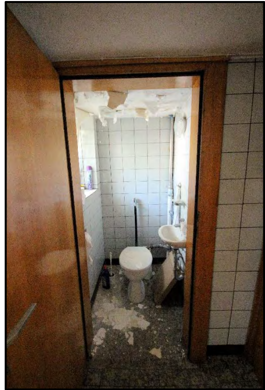
Bild 27: WC im Treppenhaus im EG
