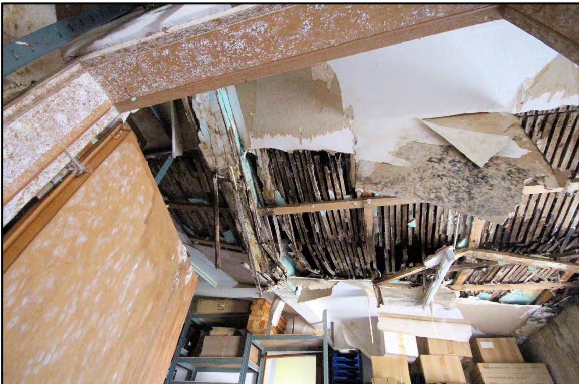
Bild 46: eingebrochene Spalierdecke und Sparren im Obergeschoss des vorderen Nebengebäudes
