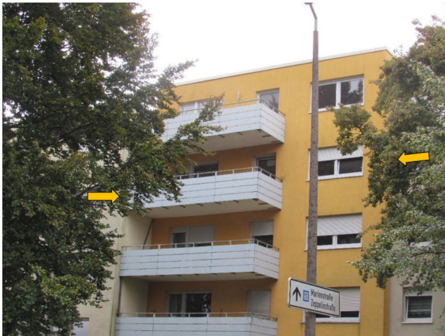
Foto 2: Wohnhaus, Wohnung 97 im 3. Obergeschoss
