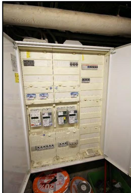
Bild 19: Zähler- und Sicherungsschrank im Kellerflur
