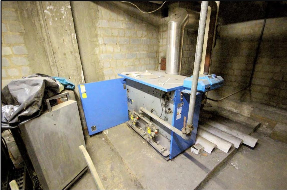
Bild 20: Gas- Heizungsanlage Fabrikat Buderus Logamatic, Baujahr 1982
