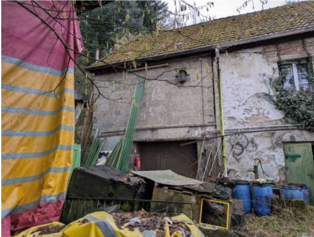
Ansicht von Norden, linker Gebäudeteil mit Garage (Anbau 1974)
