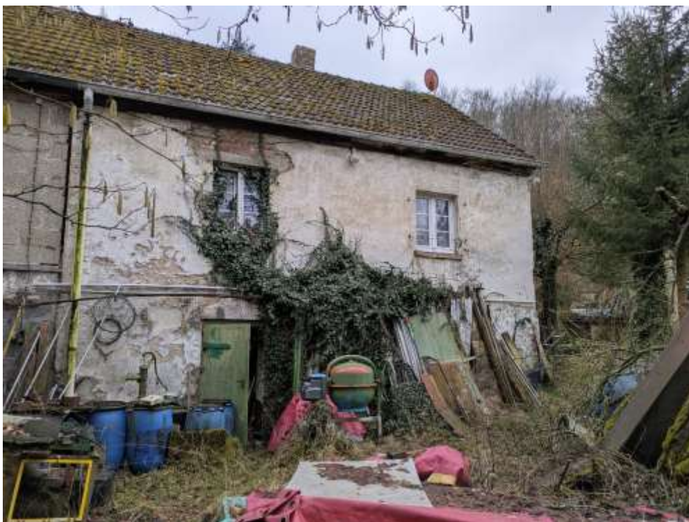
Ansicht von Norden, rechter Gebäudeteil (Altbau)
