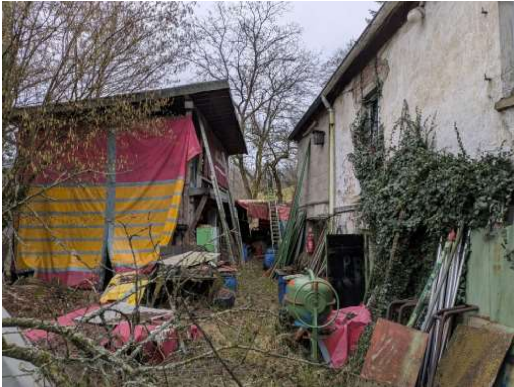
Wohnhaus rechts, Remise links (fließt nicht in die Bewertung ein)
