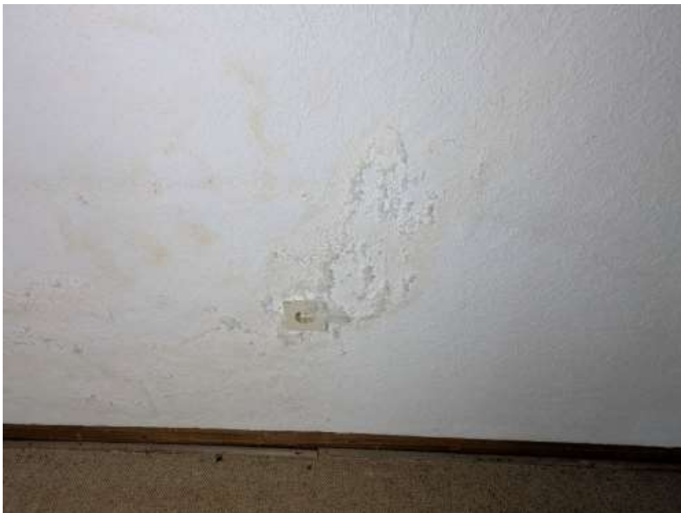
Wohnzimmer: Feuchtigkeit mit Ausblühungen an der Außenwand
