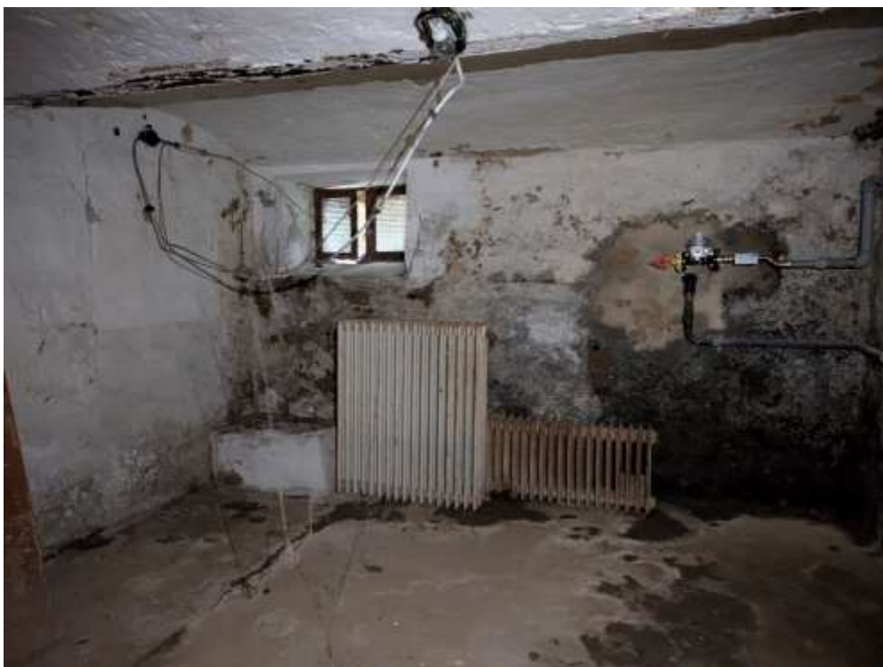
Gemeinschaftseigentum, Keller: Schäden an der Kappendecke, lose Leitungsführung
