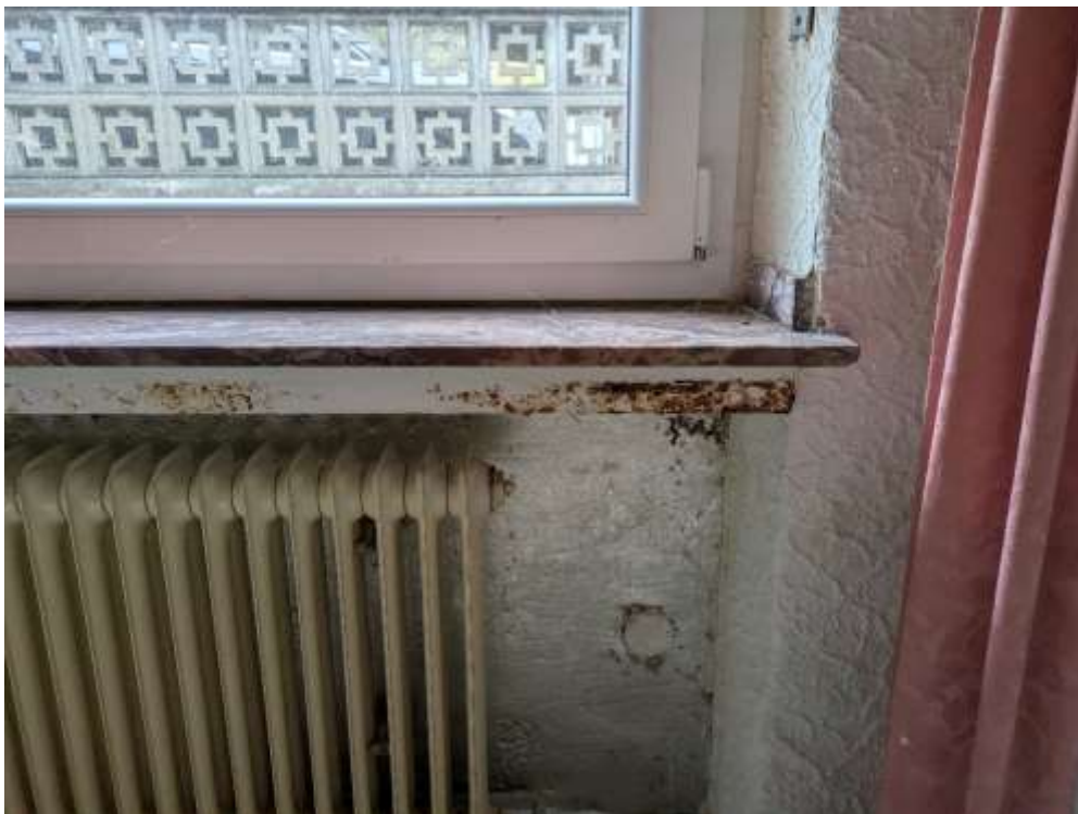
Schlafzimmer: gerosteter Stahlträger unter der Fensterbank
