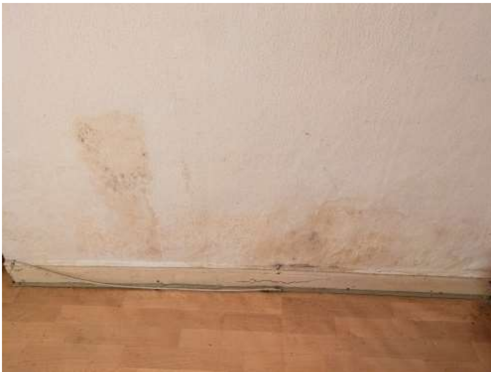
Zimmer OG: Feuchtigkeit an der Außenwand
