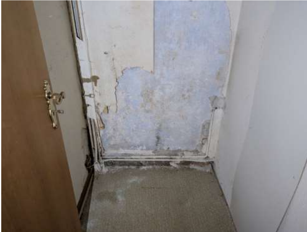
Abstellraum: Putzschaden durch Feuchtigkeit
