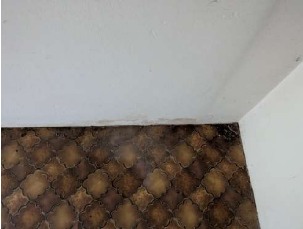
Küche: Feuchtigkeit im Übergang zum Fußboden
