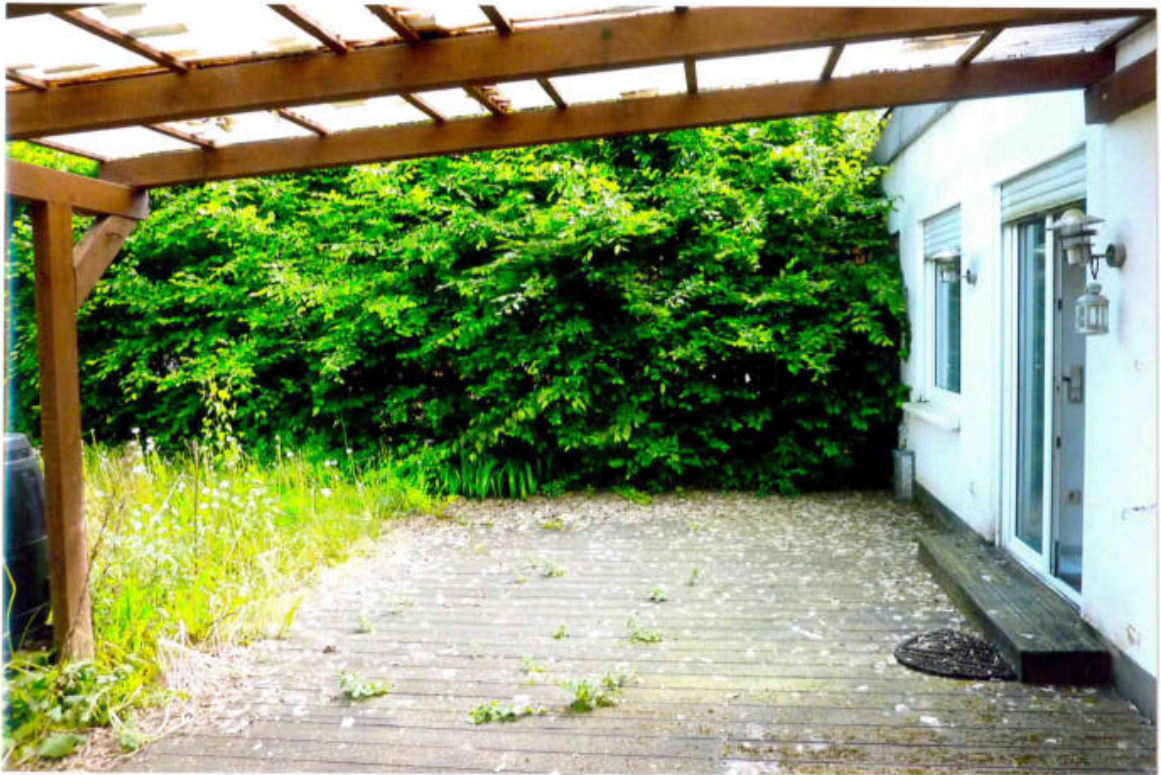
Bild 21 und 22 Vor der Wohneinheit WE 1 gelegene Holzterrasse sowie von dort Blick in den verwilderten Garten in Richtung nördlicher Grundstücksgrenze
