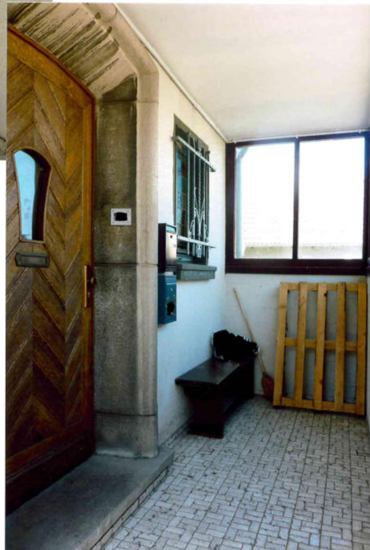
Bild 5 und 6 Zum Treppenhaus führender, über- dachter Hauseingangsbereich nebst dort gelegener Hauseingangstür
