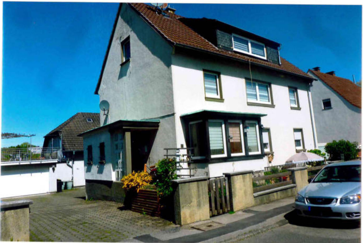
Bild 1 und 2 Straßenseitige Ansichten des zu bewertenden Dreifamilienhausgrundstücks Calvinstraße 15 in Iserlohn
