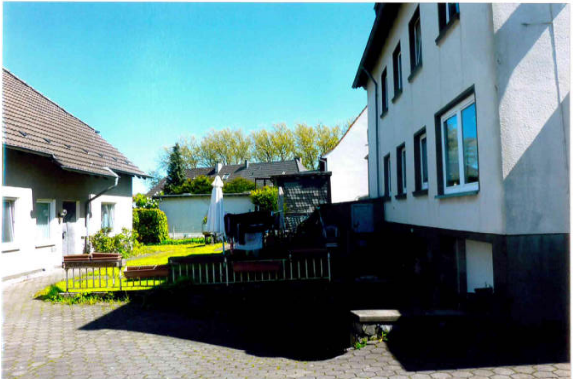
Bild 13 und 14 Blick auf die Zufahrt der rückseitig gelegenen Kellergarage sowie rückseitige Gartenfläche mit angrenzender Terrasse
