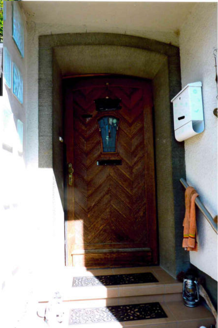
Bild 9 und 10 Zuwegung und Eingangstreppe zur Hauseingangstür der Wohneinheit WE 1
