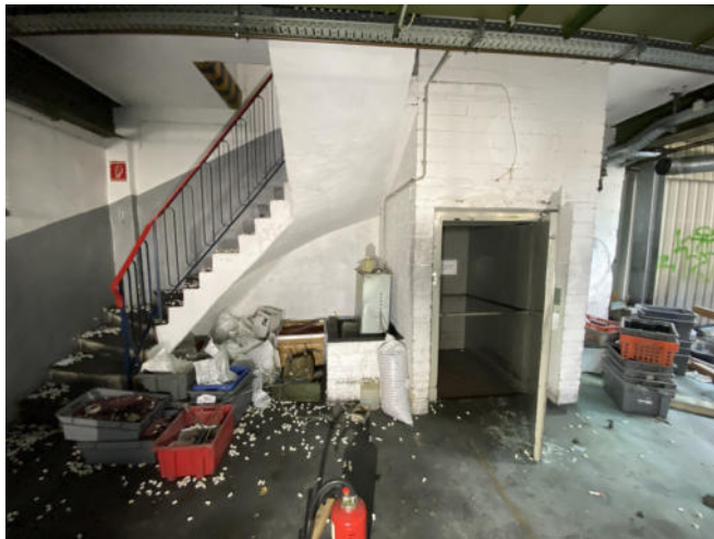
EG: Produktionshalle 02 - Lastenaufzug
