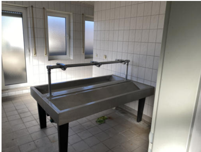
2.OG: Sanitärräume Damen mit Mehrplatzwaschbecken
