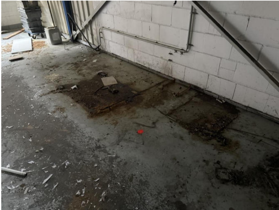
Foto 5: ehem. Standort des Kompressors – Halle 3
