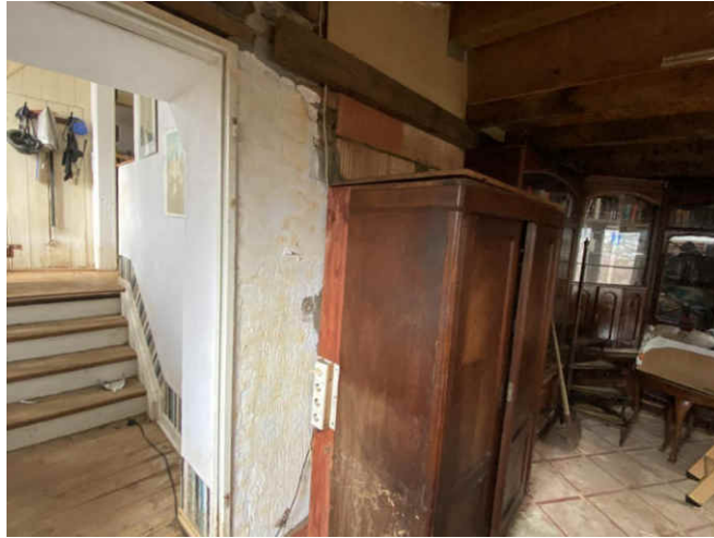
DG, Anbau, teilweise unverputzte Wand
