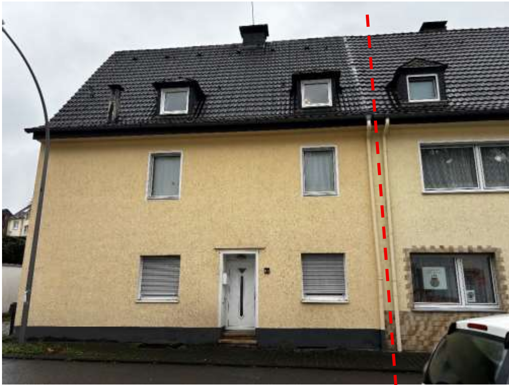
Ansicht Straßenseite (Nordwesten)
