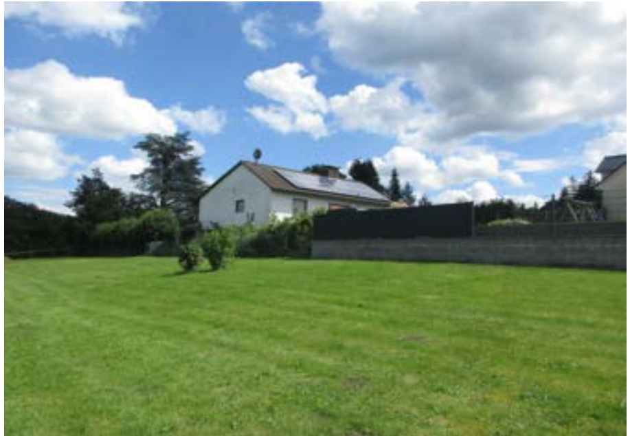
Foto 19 Nord- und Westfassade
