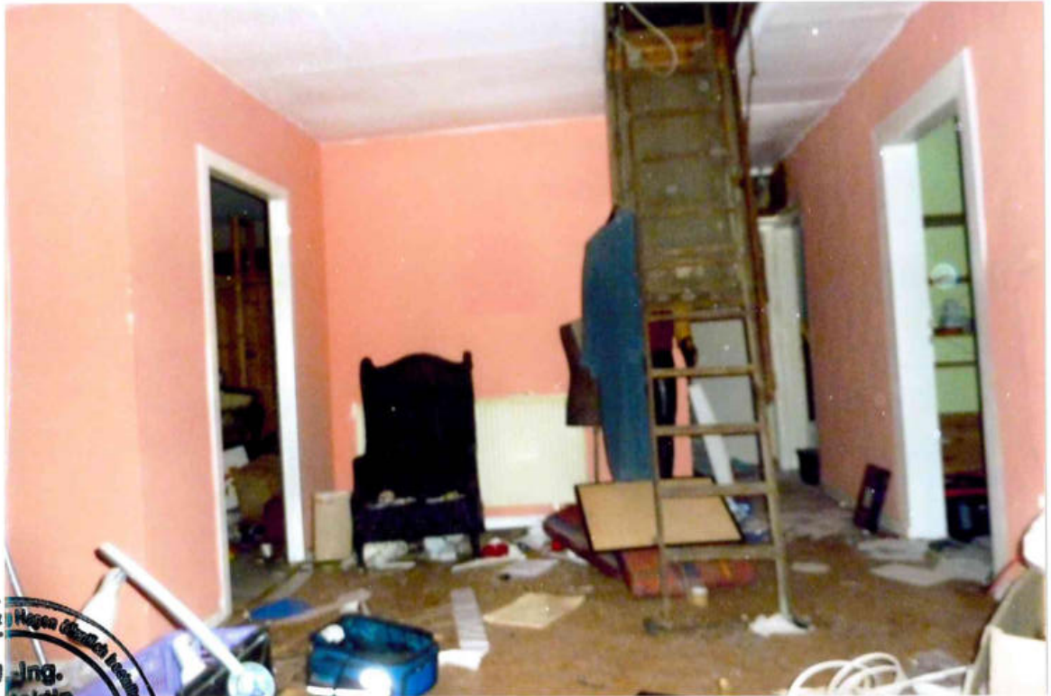
Bild 93 und 94 Die Diele der WE 6 ist ausgestattet mit zum Spitzboden führender Holzeinschubtreppe.
